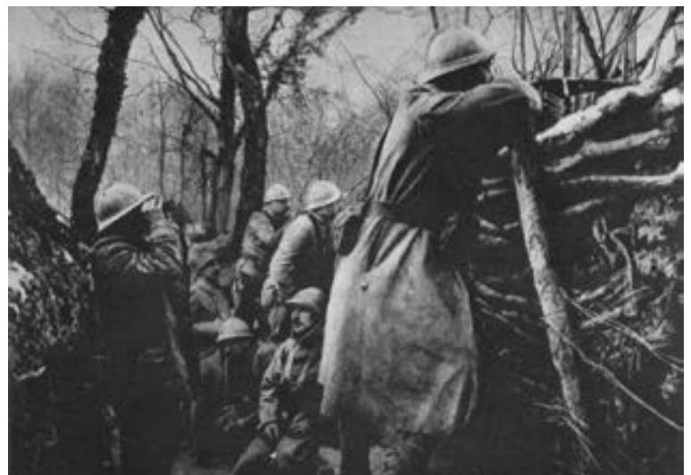
Las primeras trincheras tenían un carácter sumamente primitivo.
