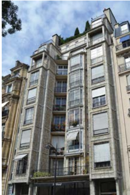
Fachada de la casa 25 de la Rue Franklin, en París, diseñada por Auguste Perret en 1902 y construida con hormigón armado.
