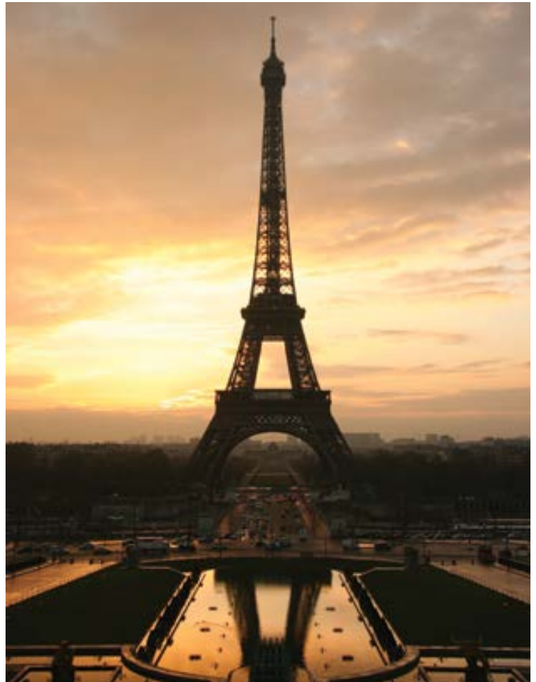
La torre Eiffel: Maravillas del acero.
