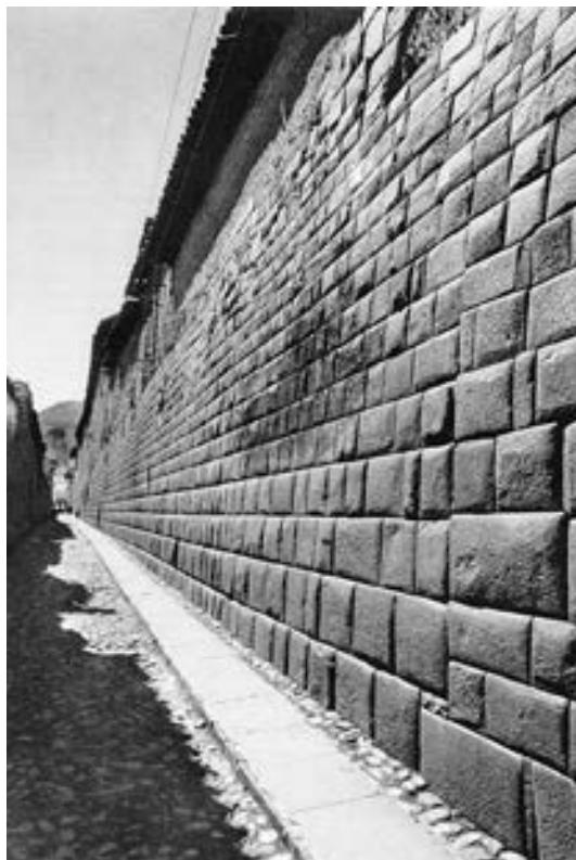
Muros ciclópeos del Cuzco.
