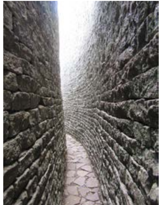
Bloques de granito, en murallas curvas de 7,5 m, en el Gran Recinto.
