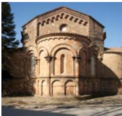
Abside del monasterio San Juan.
