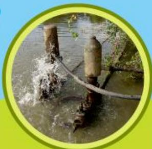
**Ariete hidráulico:** Motor hidráulico que utiliza la energía de una cantidad de agua situada a una altura mayor (el desnivel de un río, presa u otro depósito o caudal), para elevar una porción de esa cantidad de agua hasta una altura mayor que la inicial, mediante el empleo del fenómeno físico conocido como golpe de ariete.
