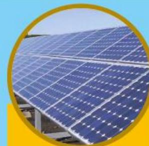
**Fotovoltaica:** La energía solar fotovoltaica es una fuente de energía que produce electricidad de origen renovable, obtenida directamente a partir de la radiación solar mediante un dispositivo semiconductor denominado célula fotovoltaica. En zonas rurales se utiliza para la iluminación y el bombeo de agua.
