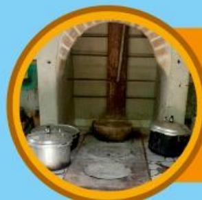
**Cocina eficiente de biomasa:** La eficiencia de estos fogones se determina por el notable aprovechamiento del calor de combustión.
