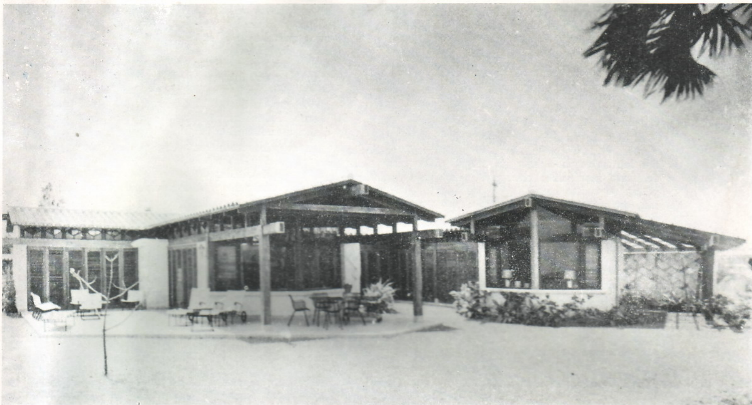
Fachada principal dando a la playa, de la residencia construídas por el arquitecto Rafael Portuondo Arnaz.
