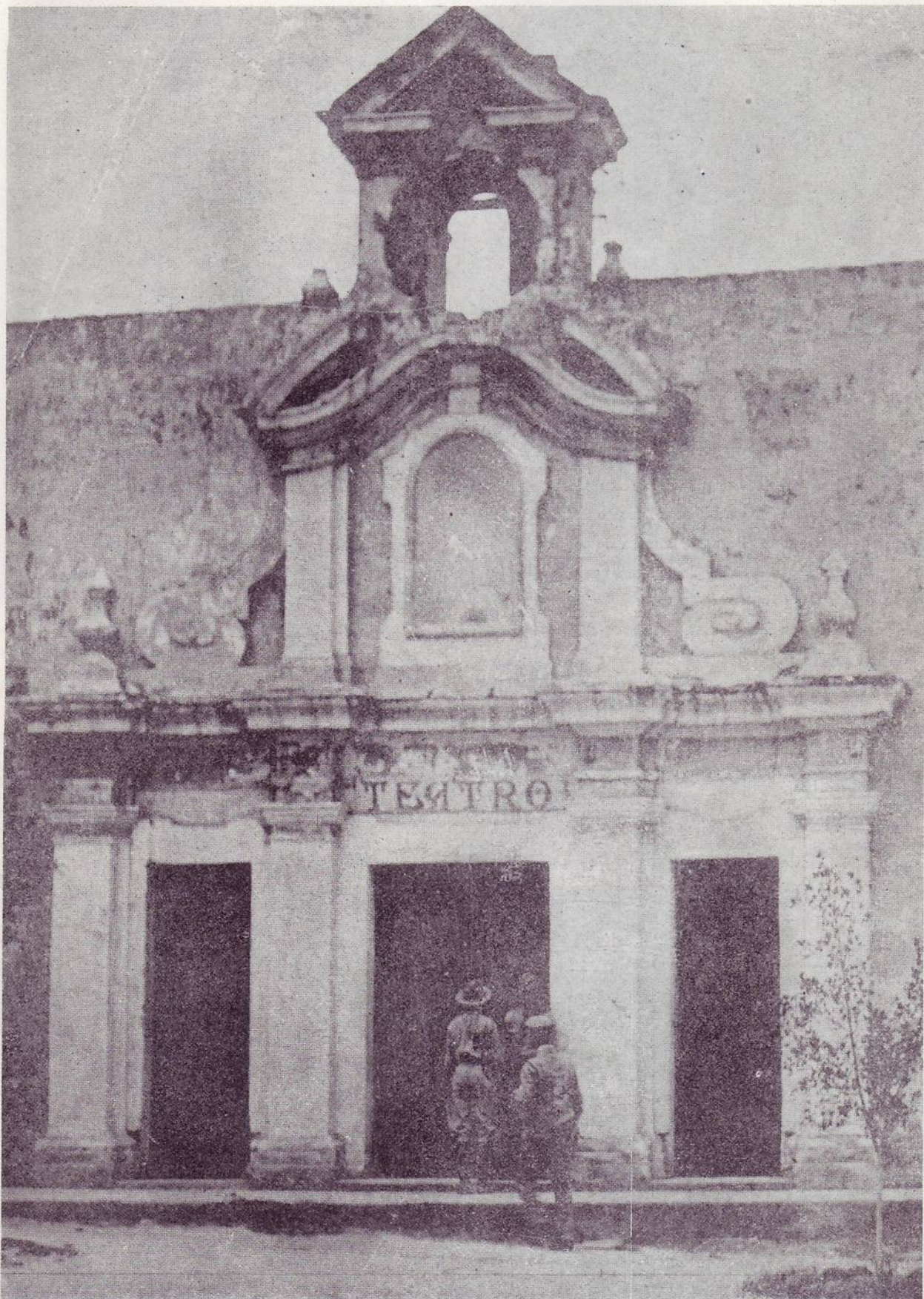
Fortaleza de la Cabaña. Fachada de la antigua capilla dedicada después a Teatro y posteriormente a Sala de Consejos del Tribunal Militar, ejecutada por el Arquitecto Pedro Medina. Véanse las similitudes que hay entre sus nichos, alerones, copas y pináculos, con otros elementos de la Catedral.
