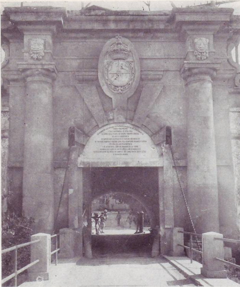
Portada de la fortaleza de San Carlos de la Cabaña. Arquitectura Militar del siglo XVIII. Con dos típicos aletones similares a los que tiene la Catedral. Ejecutada por el Arq. Pedro Medina.
