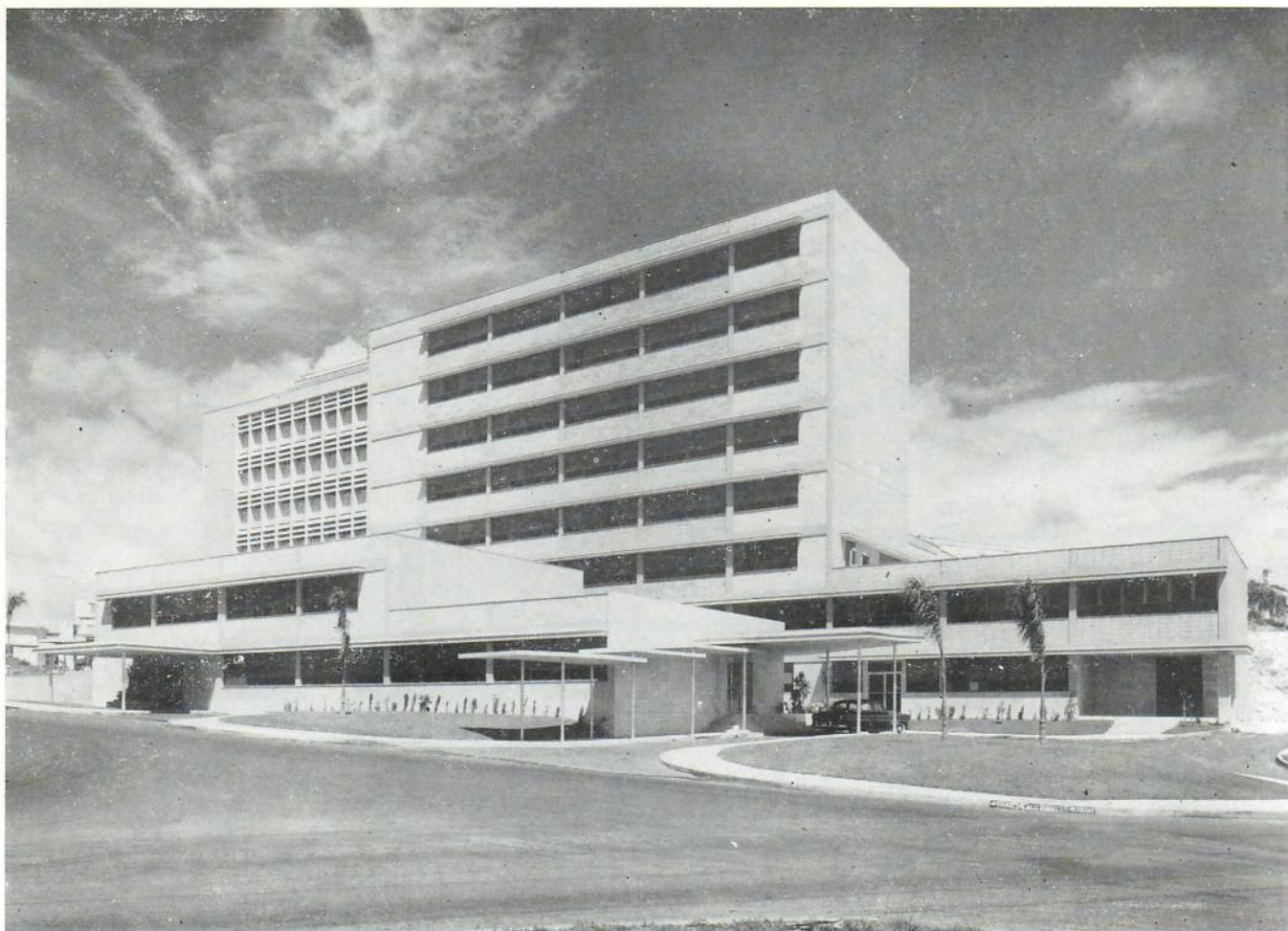
Hospital Nuestra Señora de las Mercedes, construido en la Calzada de Zapata, esq. a C, Vedado
