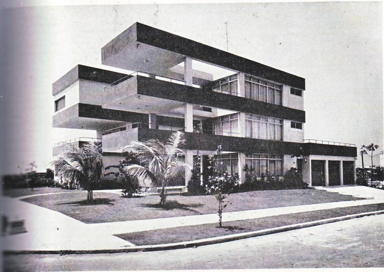
Edificio construido en la calle 62, esquina a Novena Avenida, Reparto Miramar. Propietario: Sr. José Aranalde.
