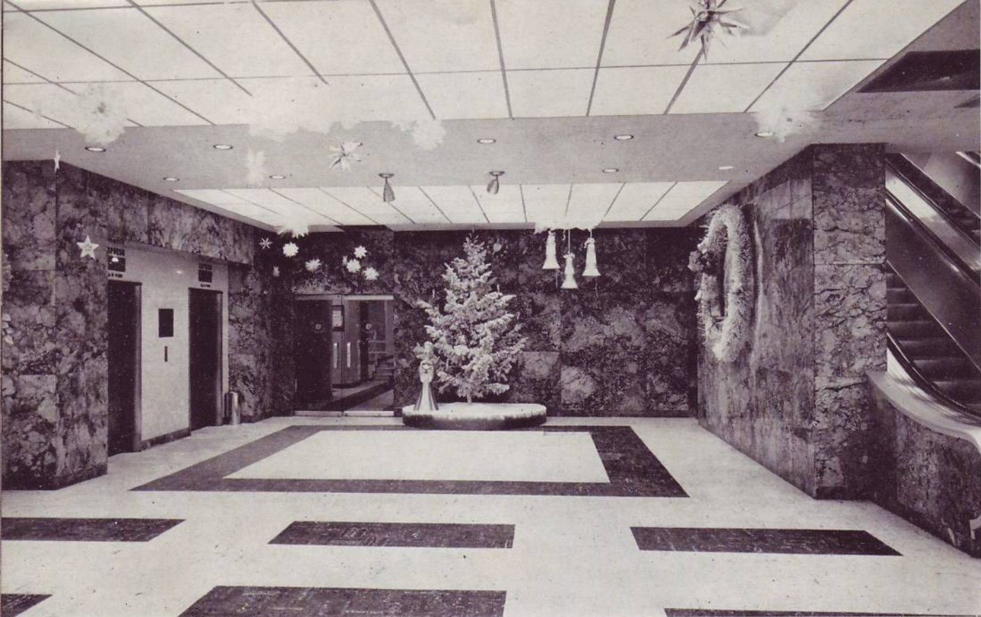
Vestíbulo de los elevadores todo cubierto de mármoles con sus techos formados por paneles luminisos.
