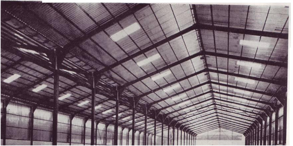
Interior del almacén de azúcar con su estructura de acero.
