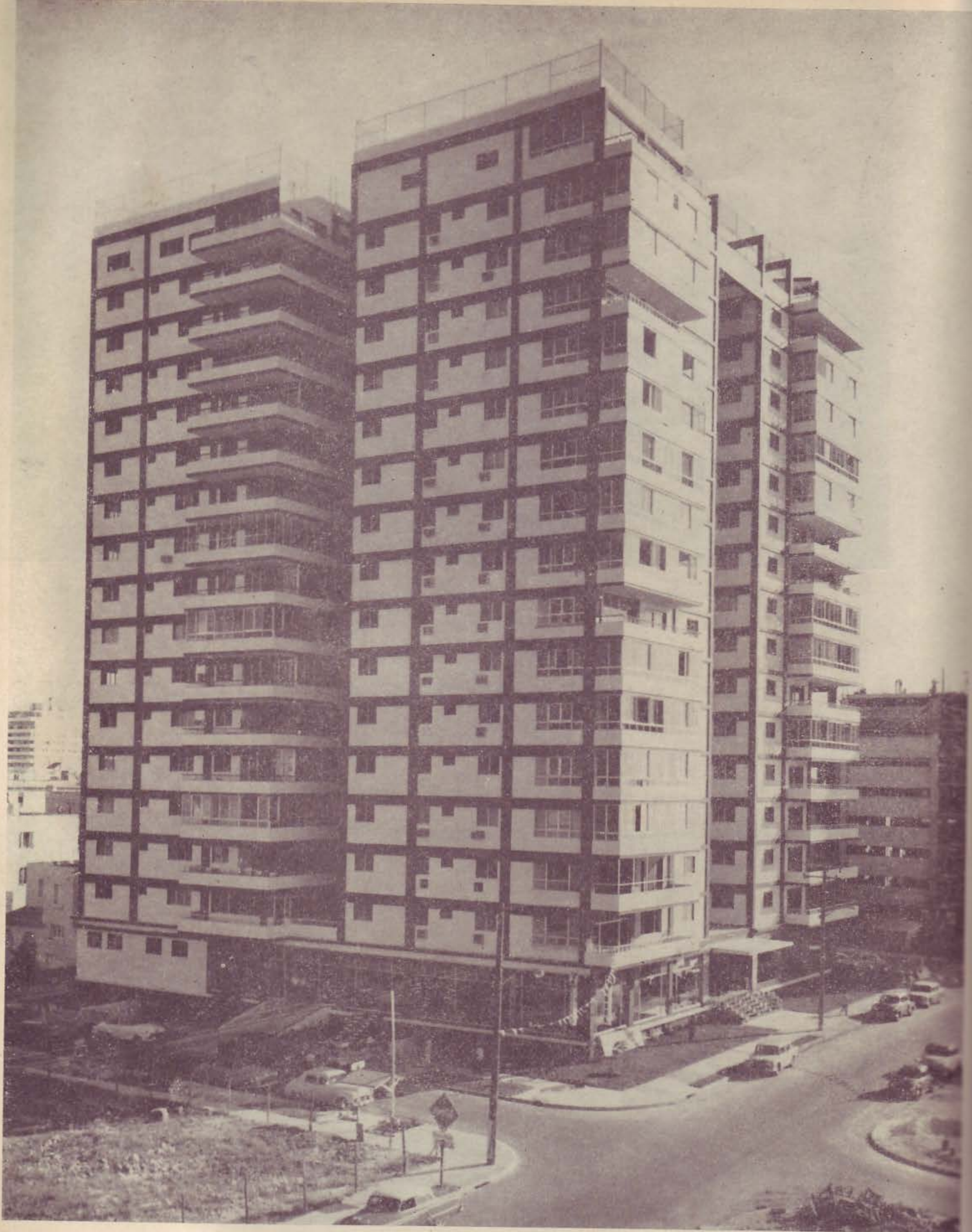
Otra vista del edificio construido por la Compañía Inmobiliaria "15 Pisos, S. A.", en Primera y B. Vedado por el Arquitecto Laureano Cancio Prades y los Contratistas Rabassa y Castillo. Fotografía por Servifoto.
