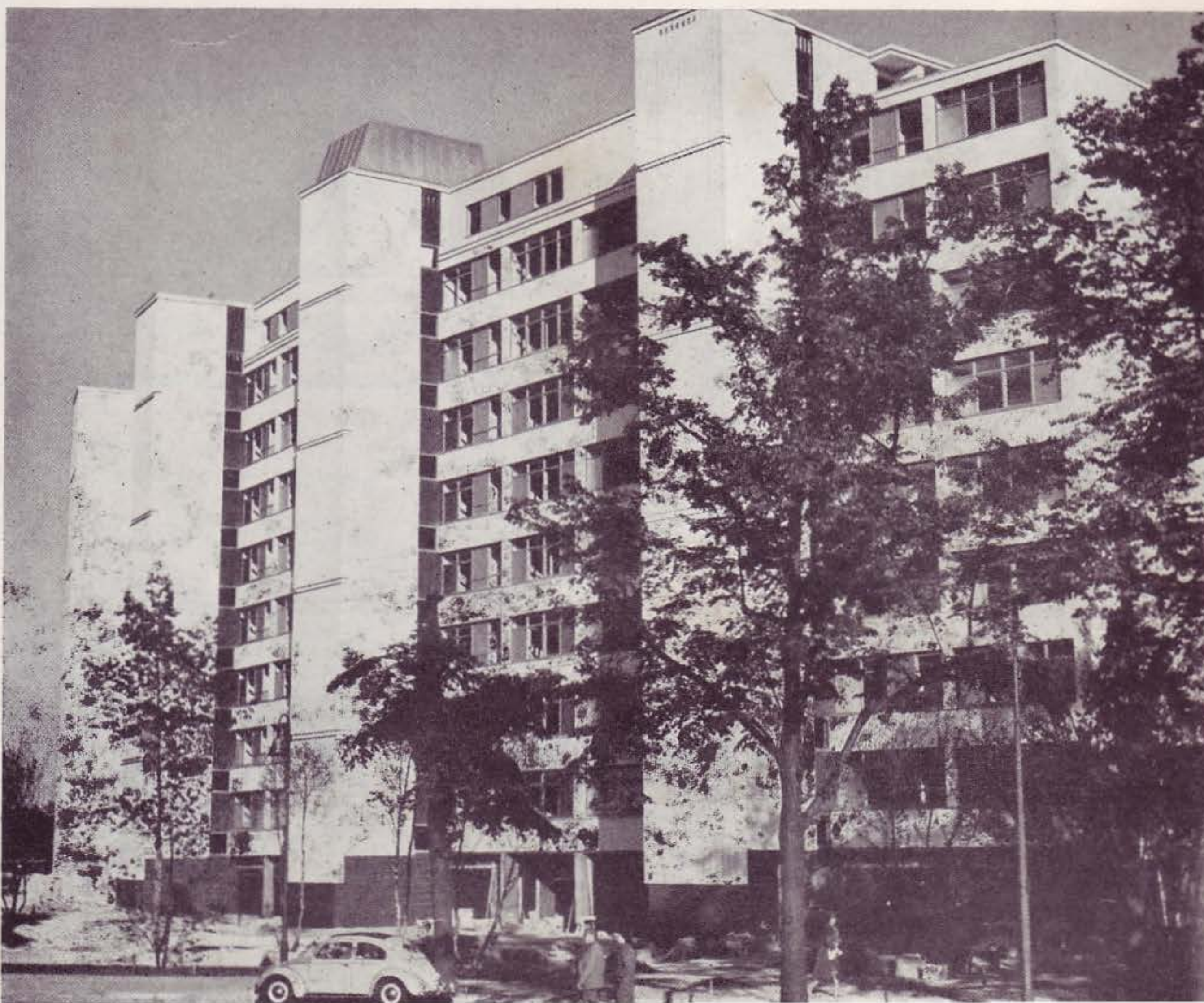
Vista de la fachada posterior del bloque de viviendas construidas por el Profesor W. Gropius con los volúmenes salientes de las escaleras.
