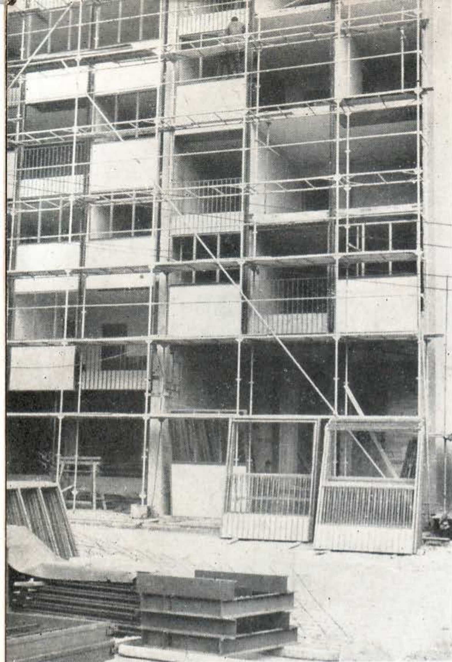
Vista del edificio torre, construido por los Arquitectos López y Beaudoin, durante la construcción, donde se emplearon elementos pre fabricados en las fachadas.
