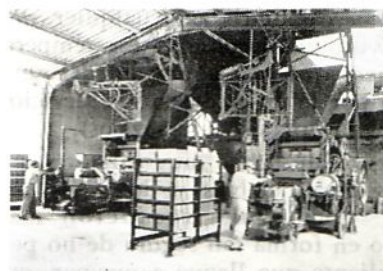
Las dos maquinas Besser Vibrapac en funcionamiento
