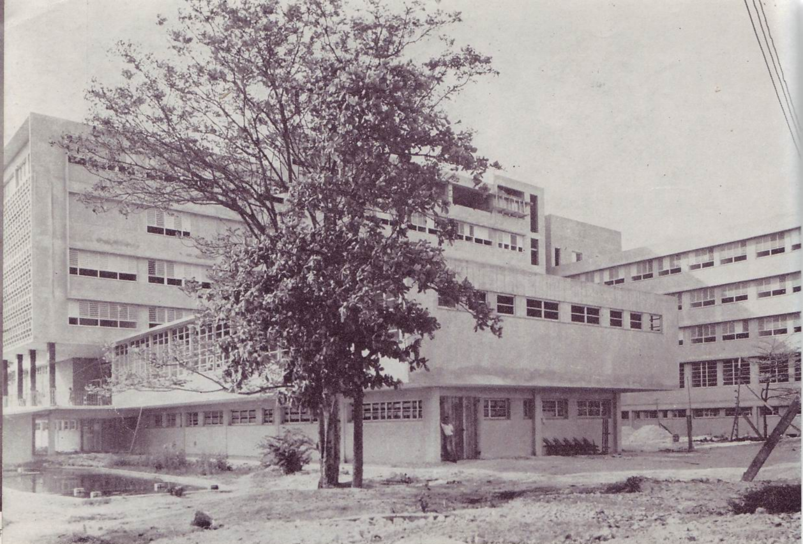
Vista lateral del Hospital Clínico Quirúrgico, observándose la entrada al patio central donde se encuentra el cuerpo de guardia.
