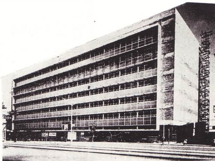
Caja Retiro Eléctrico. Jorge Luis Echarte, Arquitecto.
