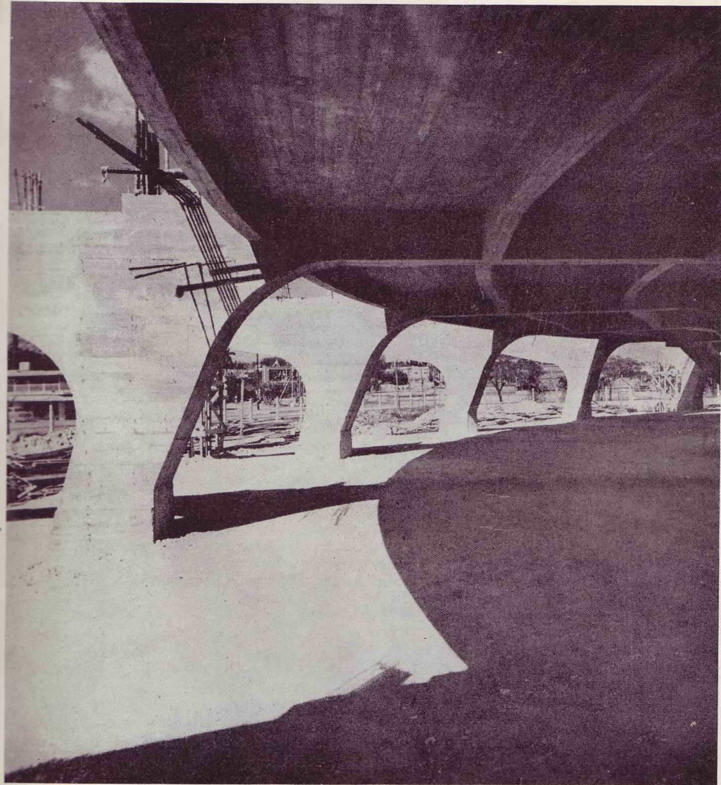
VISTA DE LOS APOYOS DE LA ESTRUCTURA DE LA PLANTA PRINCIPAL DEL PALACIO DE LOS DEPORTES, CON EL VOLADIZO QUE SOPORTARA LAS OFICINAS. NICOLAS ARROYO MARQUEZ, ARQUITECTO.
