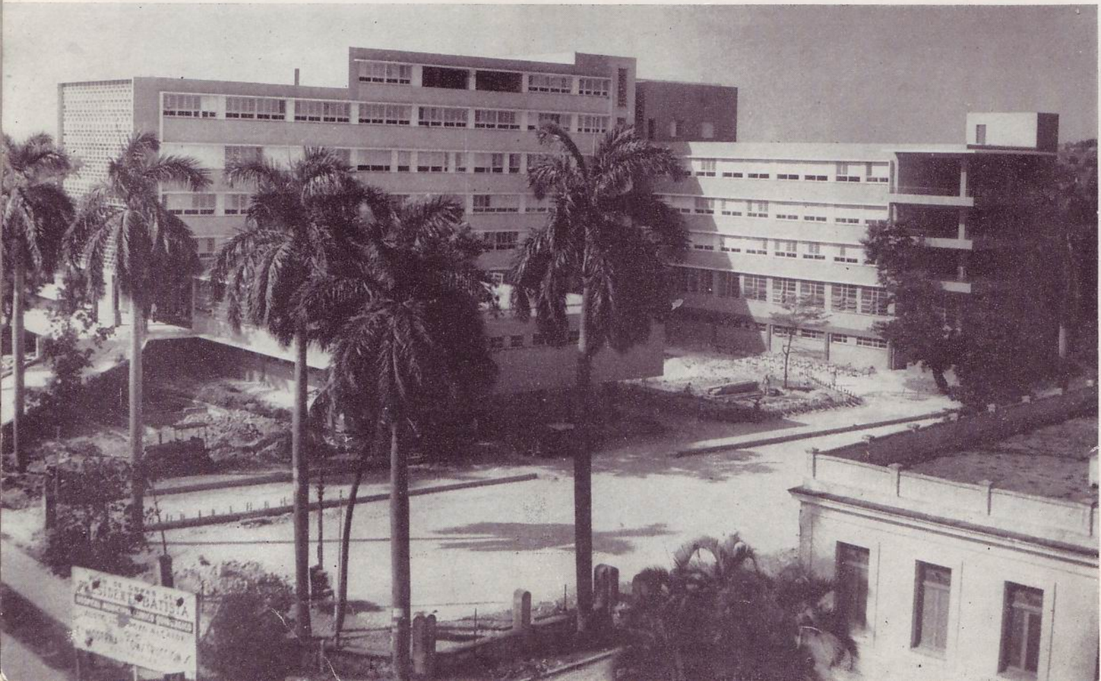
Otra vista de ángulo del Hospital Municipal Clínico Quirúrgico, construido dentro de un parque en terrenos de la Finca La Ciénaga. Carlos M. Maruri, Arq. Dr. Rolando Pozo Jiménez, Director Técnico.
