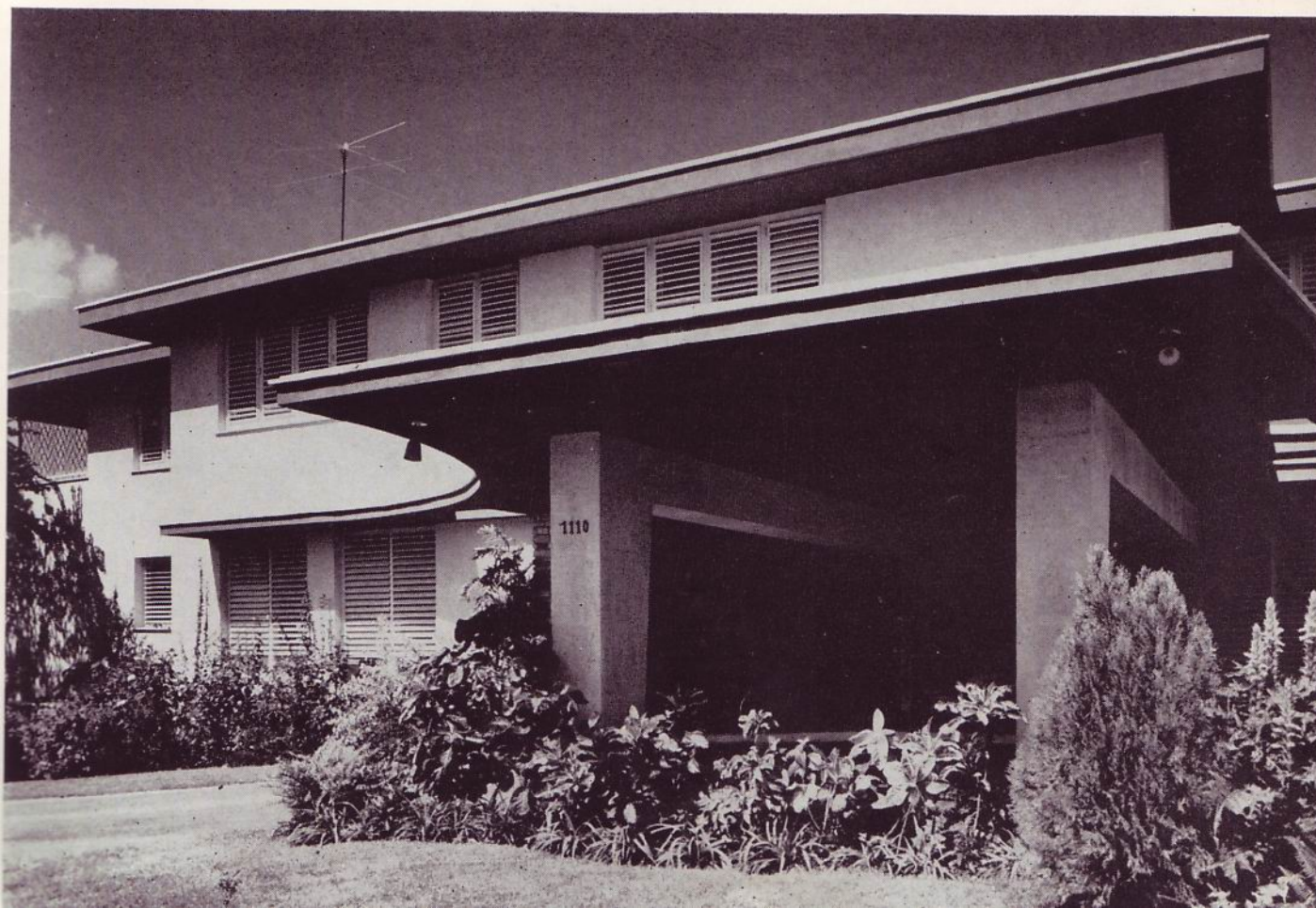
Un detalle del gran porche cubierto con la entrada principal. Morales y Cía., Arquitectos.
