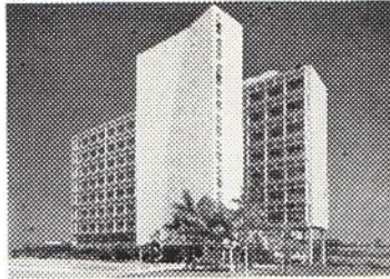
EDIFICIO DEL TRIBUNAL DE CUENTAS Arquitecto Proyectista Aquiles Capablanca
