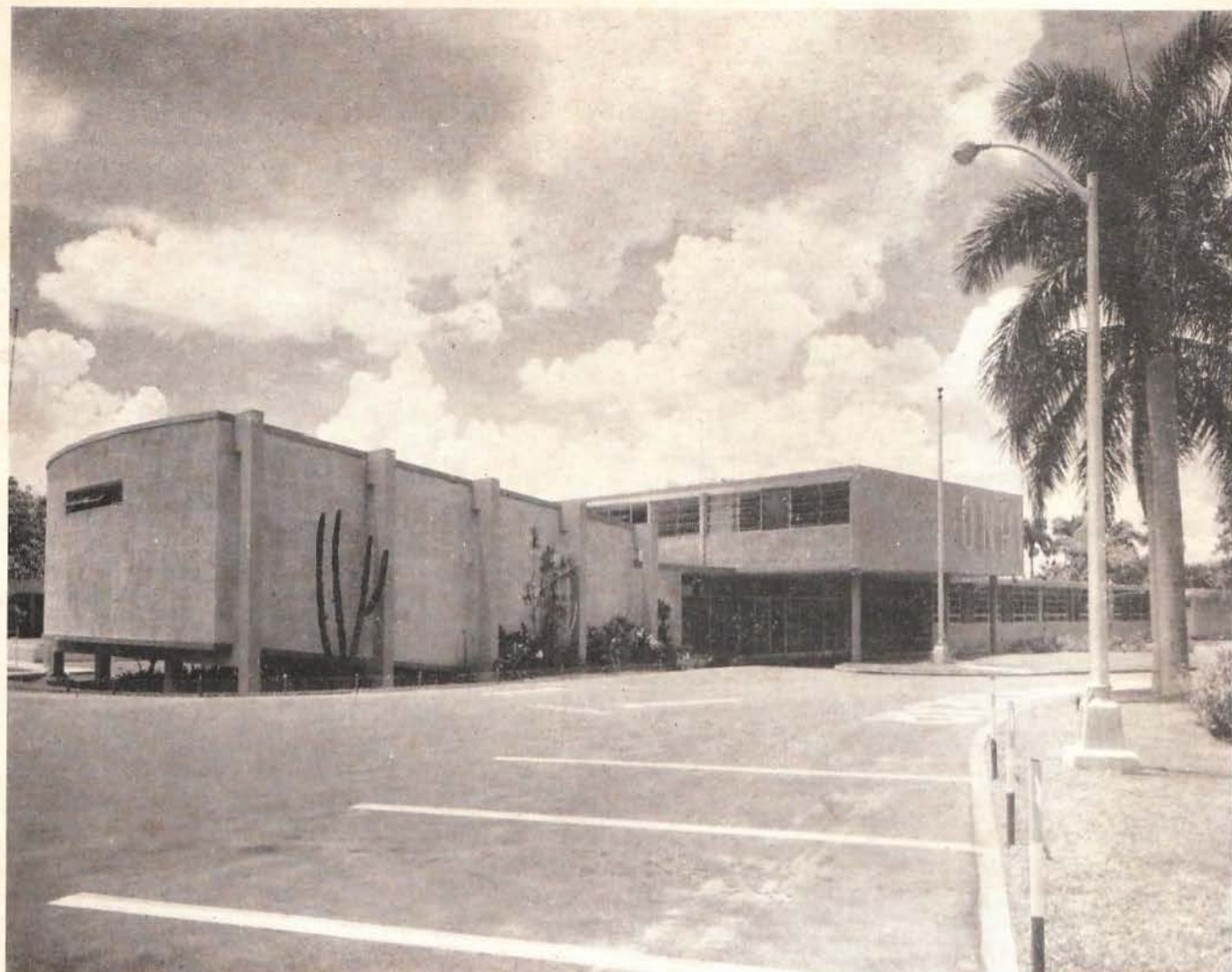
Organización Nacional de Rehabilitación de Inválidos. Hospital Central en La Lisa, Mariacó. Arquitectos: Nicolás Arroyo y Gabriela Menéndez.
