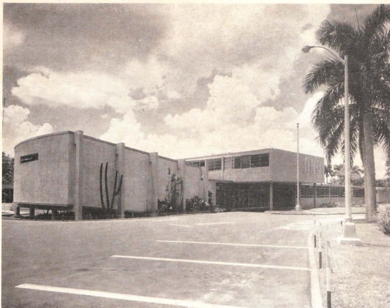
Organización Nacional de Rehabilitación de Inválidos. Hospital Central en La Lisa, Marianco. Arquitectos: Nicolás Arroyo y Gabriela Menéndez.
