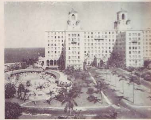
Hotel Nacional Reparaciones Arquitecto: Ricardo Franklin.
