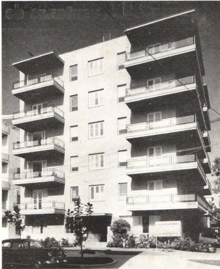
Edificio de Apartamentos construido en Calzada y 8, Vedado. Propietario: Dr. Vicente Banet. Arquitectos: Albarrán y Bibal.
