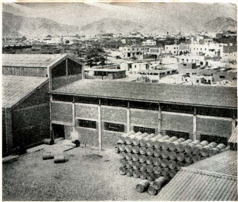
Una buena administración industrial permite que una fábrica armonice perfectamente con una zona residencial.
