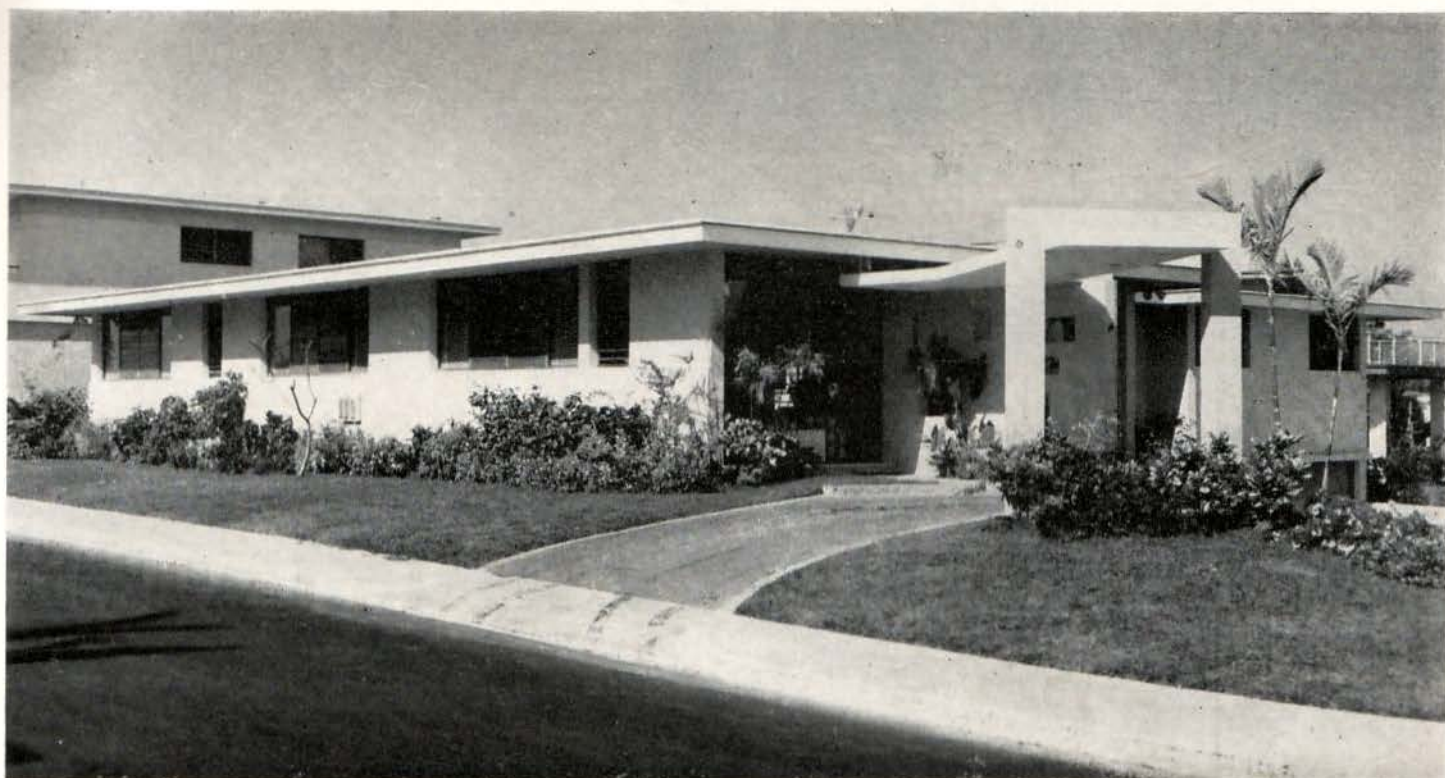
Fachada con la entrada principal bajo el porche cubierto de la residencia del Sr. Jaime Canavés, en Alturas del Vedado. José Canavés, Arquitecto.
