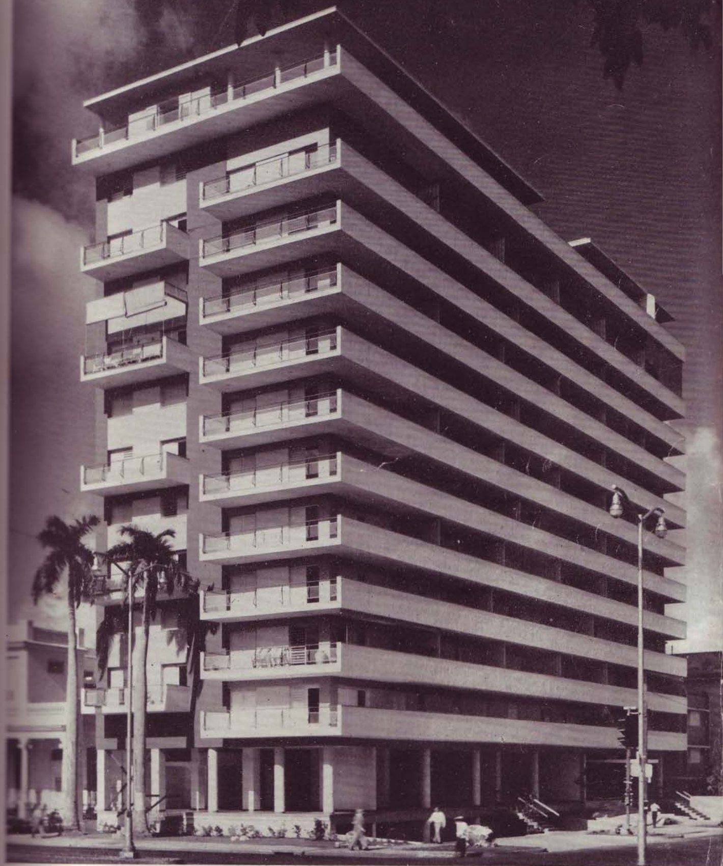
Edificio de Propiedad Horizontal construido en la esquina de las Avenidas Línea y Paseo, en el Vedado.
