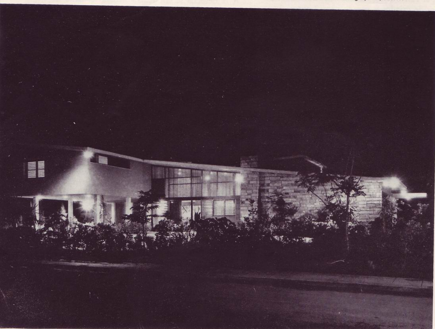
Vista lateral de la residencia construída en el Reparto Biltmore. Raúl J. Martínez Vargas, Arquitecto.
