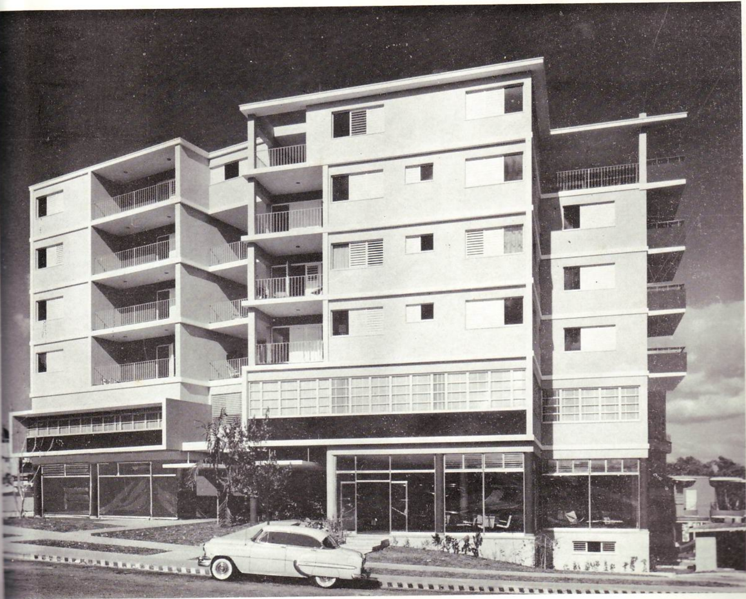
Edificio de oficinas y comercio en la planta baja y plantas típicas con apartamentos en las siguientes y un Pent-House en la última planta, construido en la Avenida 26 y Avenida del Zoológico, Alturas del Vedado.
