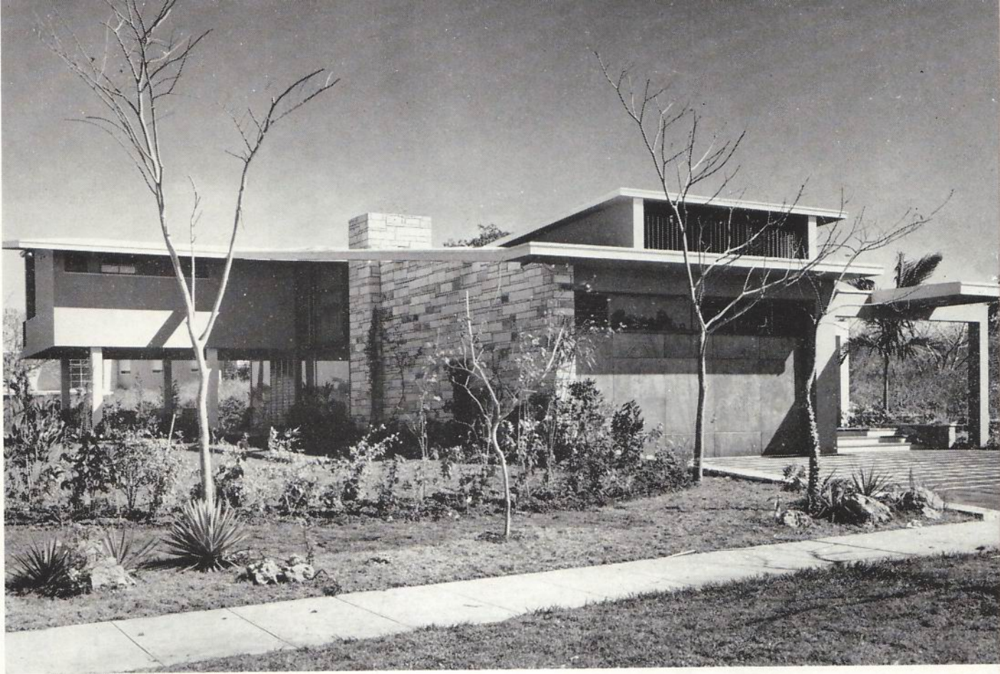
Fachada lateral. Arquitecto Raúl J. Martínez Vargas.
