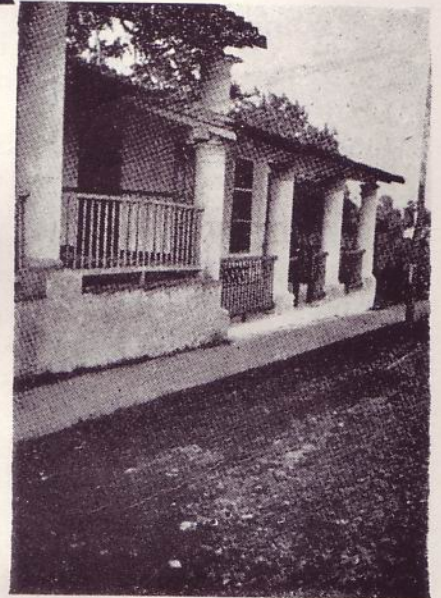
Anomalia de las columnas producida por la diferencia de nivel de los portales y la altura del techo del colgadizo.
