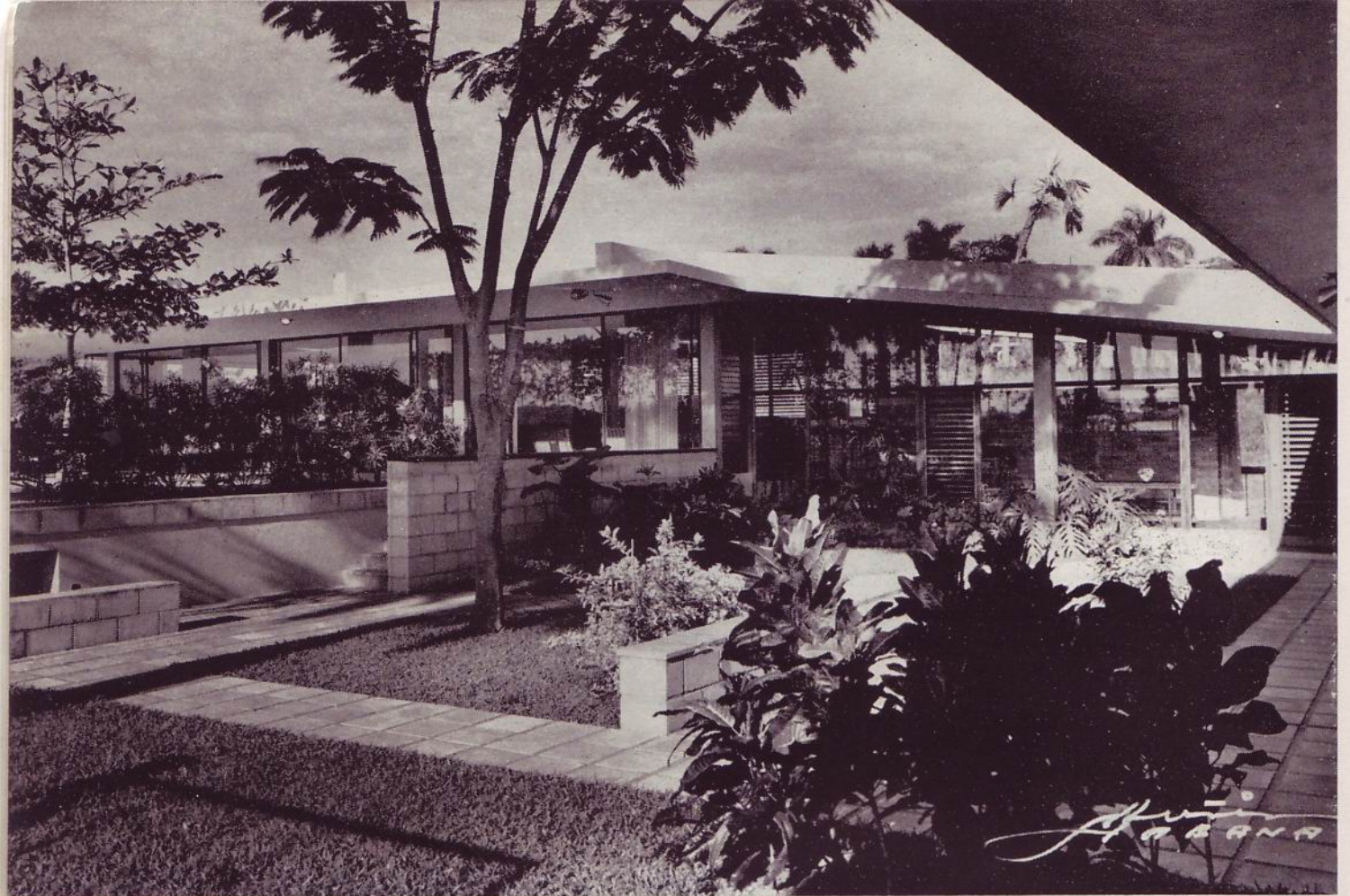
EL PREMIO MEDALLA DE ORO DE 1955. Fachada lateral de la residencia de la Sra. Evangelina Aristigueta de Vidaña, construída en el County Club por los Arquitectos Silverio Bosch y Mario Romañach.
