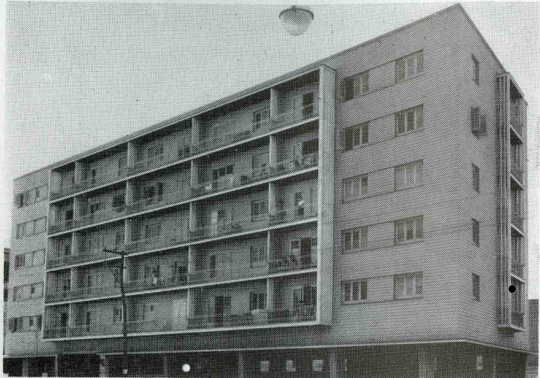
Todos los apartamentos del moderno Edificio "Centro Cívico" en Ayestarán y 20 de Mayo, construido por la acreditada firma G. del Valle - G. Nava, han sido equipados con cocinas de gas MAGIC CHEF.
