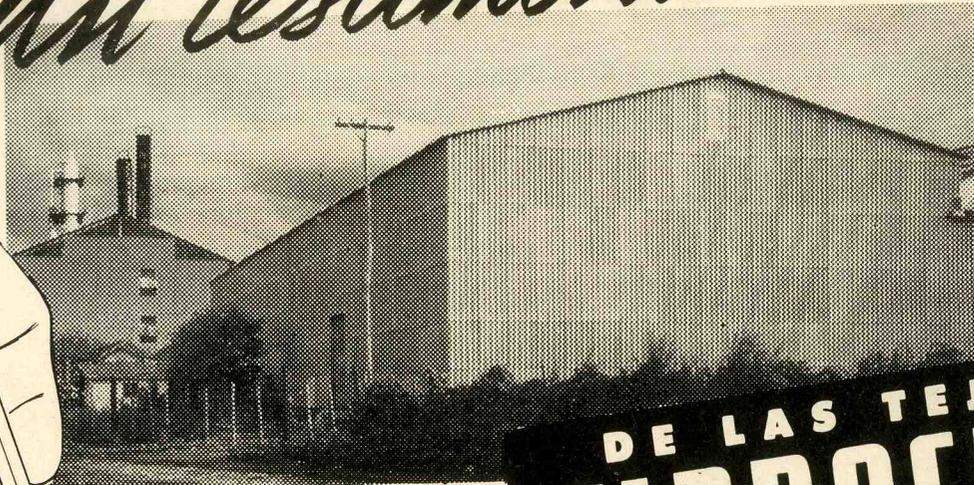
Nave destinada a Almacén de Azúcar del Central "JOSEFITA" ubicado en Palos, Provincia de La Habana Paredes y techos cubiertos con planchas acanaladas FIBROCEM.
