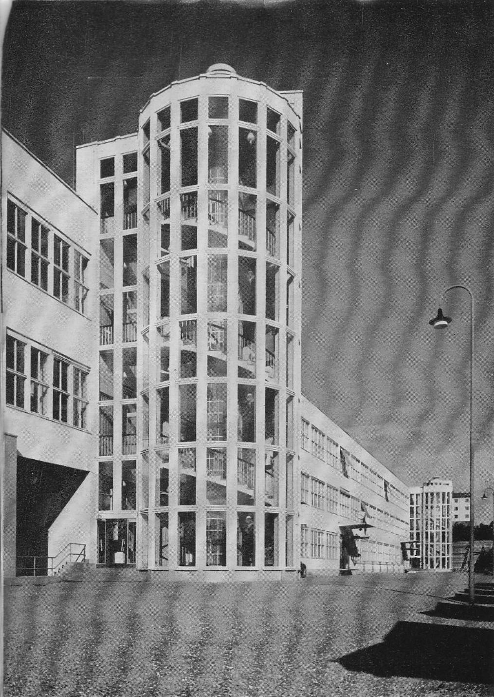
DETALLE DE LA CENTRAL DE TELEFONOS EN ESTOCOLMO. FOTO: L. M. ERICSSON.
