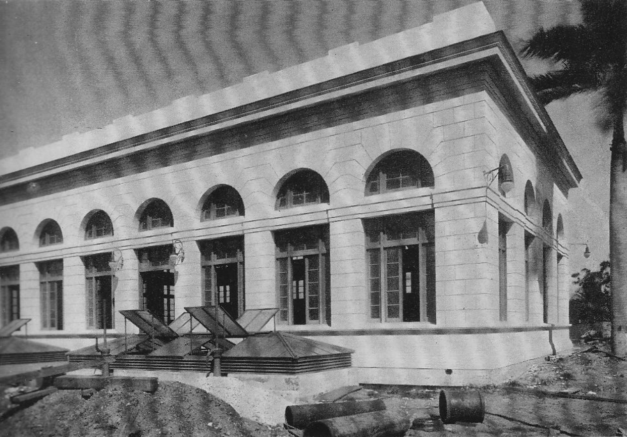
PLANTA DE BOMBAS TURBO-ELECTRICAS DE PALATINO. FACHADA PRINCIPAL
