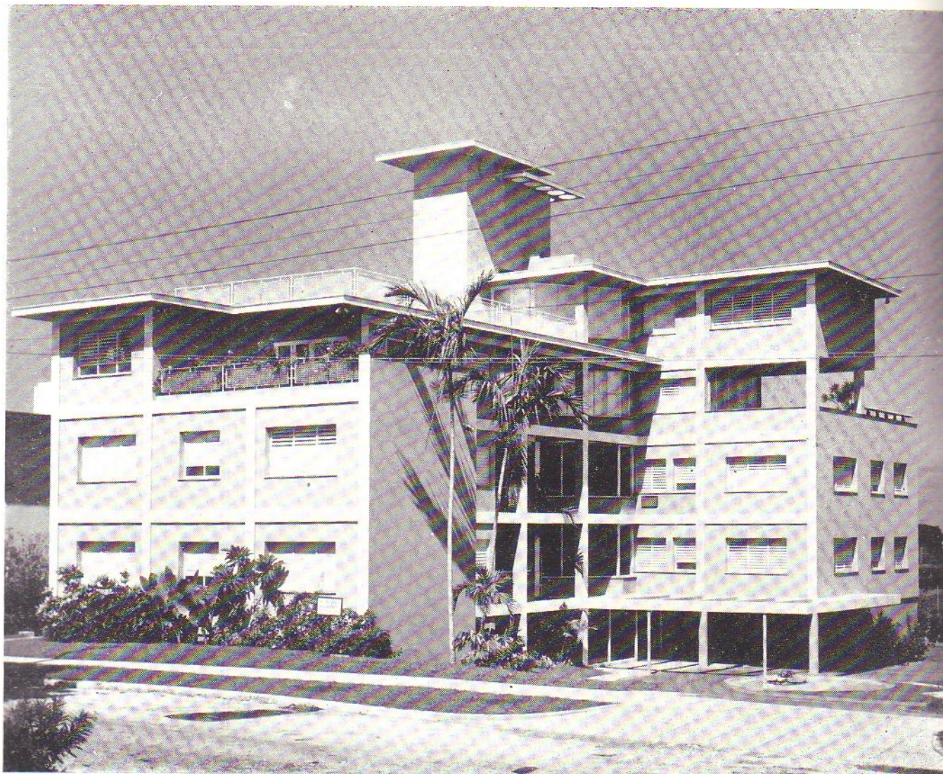
Edificio de apartamentos construido en el Reparto Miramar, Marianao. Propietaria: Sra. Carmen Casteleiro de Salaya. Arquitectos: Nicolás Arroyo y Gabriela Menéndez.
