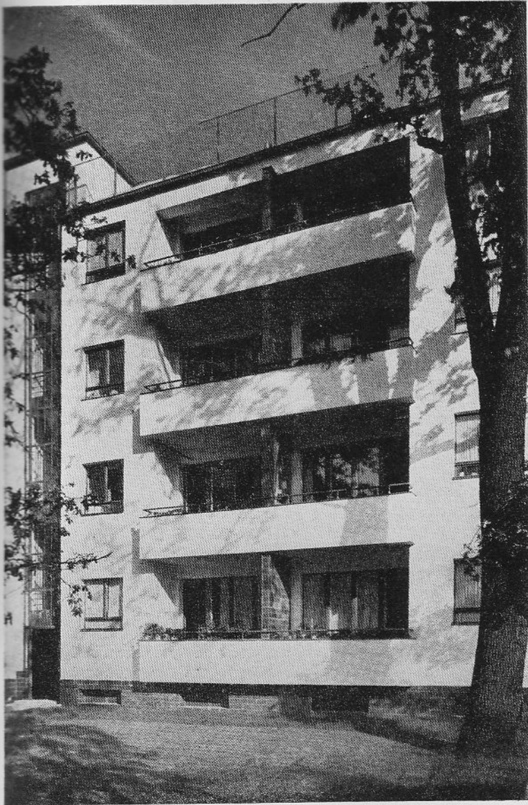
EDIFICIO DE APARTAMENTOS EN LA SIEMENSSTADT SIEDLING, BERLIN. WALTER GROPIUS, ARQUITECTO.
