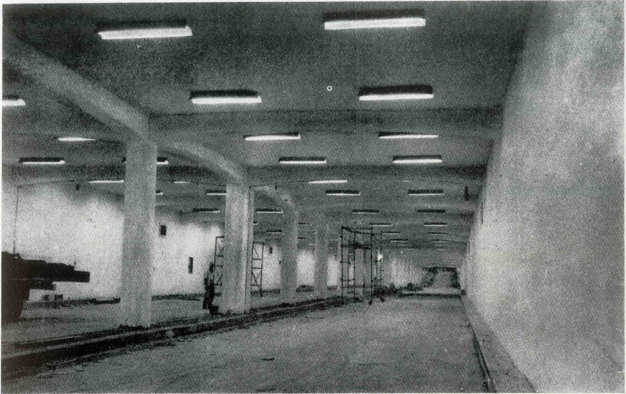
CARACAS. AVENIDA BOLIVAR. VISTA INTERIOR DE LA VIA SUBTERRANEA DE NOCHE CON LA CLARIDAD EXTRAORDINARIA QUE OFRECE. AL FONDO, SE VE EL COMIENZO DE LA RAMPA DE SALIDA AL EXTERIOR.
