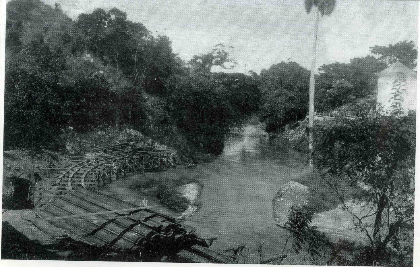
VISTA GENERAL DEL RIO ALMENDARES AL SER COMENZADAS LAS OBRAS. A LA IZQUIERDA, DEBAJO, LAS TABLESTACAS DE ACERO DE LA ATAGUIA DEL MAINE.
