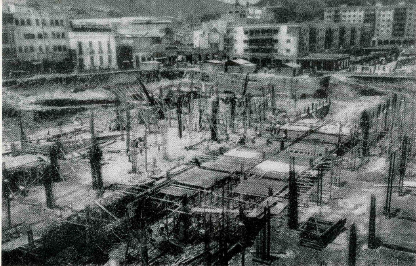
CARACAS. AVENIDA BOLIVAR. LA VIA SUBTERRANEA YA PARCIALMENTE ENCOFRADA EN LA PRIMERA MANZANA EL DIA 31 DE JULIO DE 1949, DESPUES DE HABERSE TERMINADO LOS GRANDES TRABAJOS DE DEMOLICION DE LOS EDIFICIOS QUE ALLI SE ENCONTRABAN.
