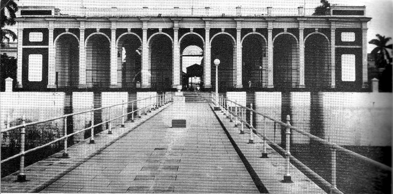
VISTA DEL PABELLON Y DEL MURO CENTRAL ENTRE LOS DEPOSITOS.
