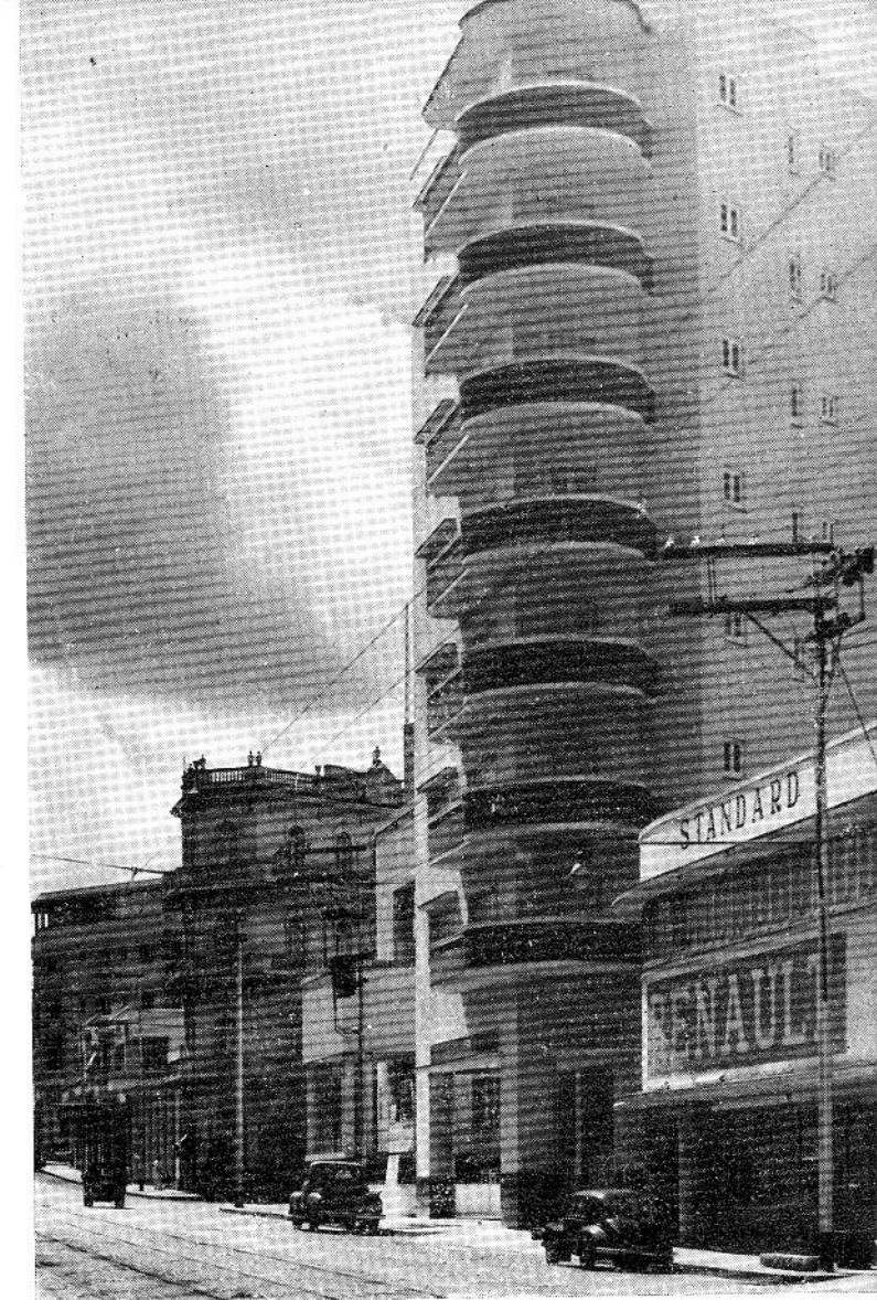
MOTIVO DE ANGULO DEL EDIFICIO DE LA CAJA DE JUBILACIONES Y PENSIONES SITUADA EN INFANTA No. 26. PROYECTISTAS: ARQUITECTOS ARMANDO PUNTES, LUIS BONICH y ROBERTO L. FRANKLIN. DIRECTOR FACULTATIVO: EMILIO VASCONCELOS.
