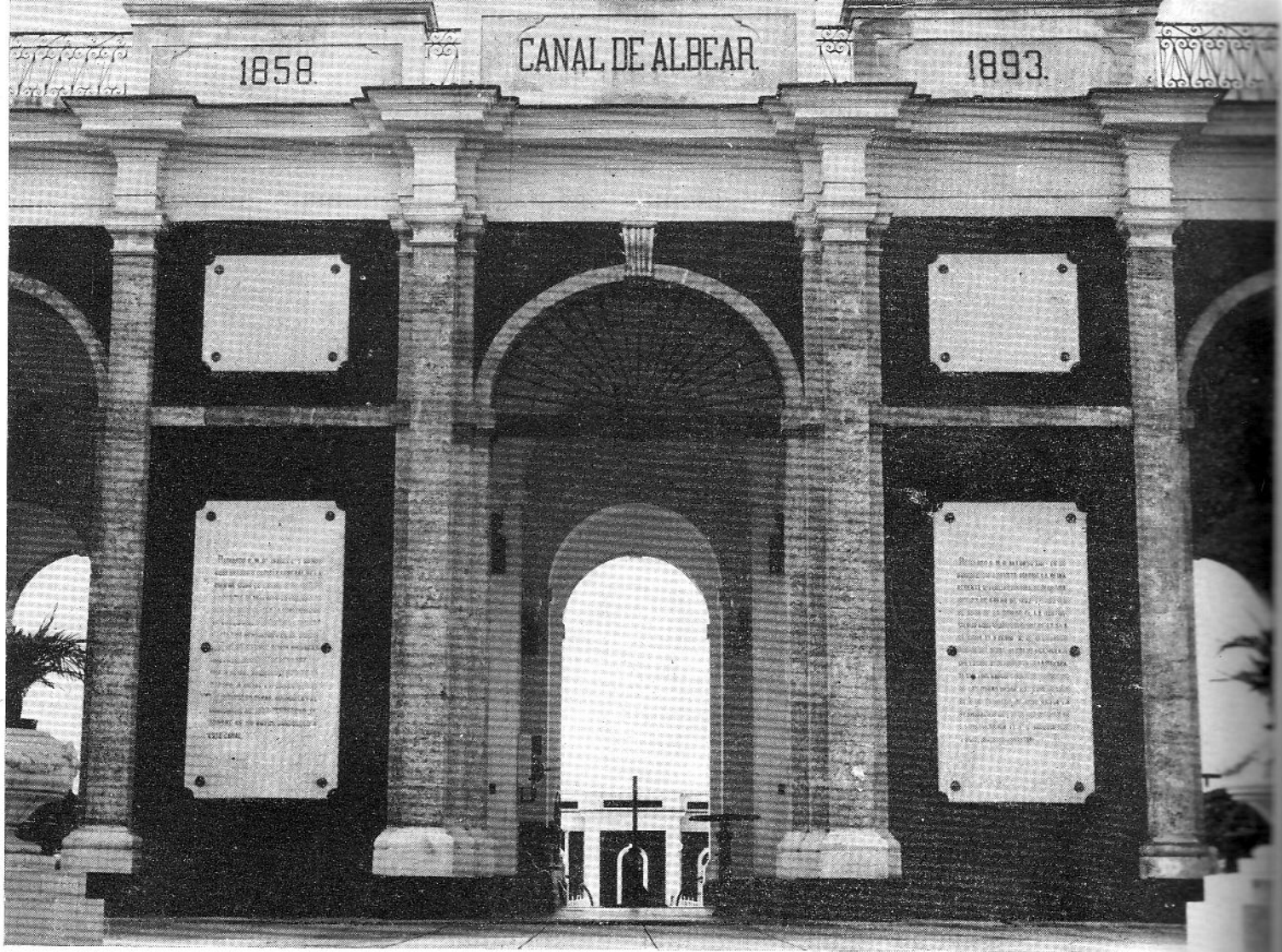
DEPOSITOS. — FACHADA PRINCIPAL DEL PABELLON SOBRE EL FOSO DE MANIOBRAS DE LAS VALVULAS. VISTA DESDE LOS JARDINES.
