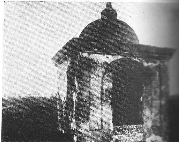
ACUEDUCTO DE FERNANDO VII.—UNA DE LAS TORRES DE PIEDRA A LO LARGO DE LA TUBERIA DE HIERRO FUNDIDO
