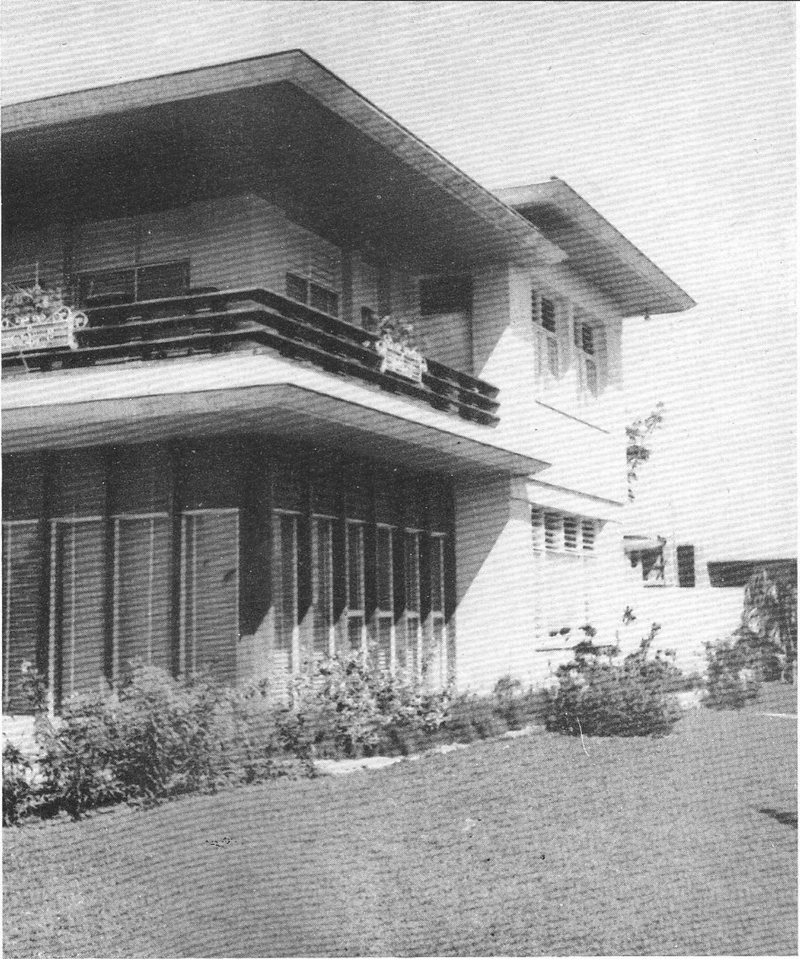
OTRA VISTA DE ANGULO DE LA RESIDENCIA DEL SR. JOSE RODRIGUEZ.—ANTONIO BOADA SABATES, ARQUITECTO
