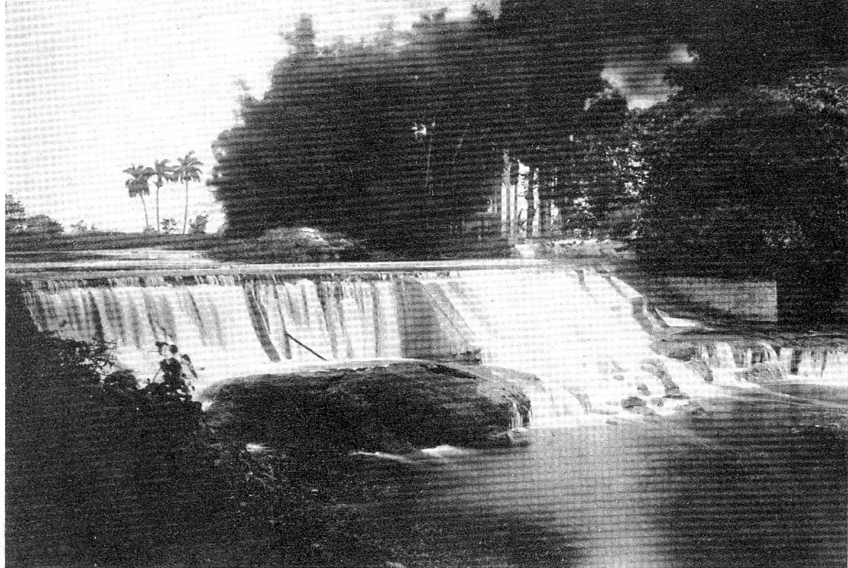
LA ANTIGUA REPRESA DEL HUSILLO EN UNA CRECIDA DEL RIO ALMENDARES
