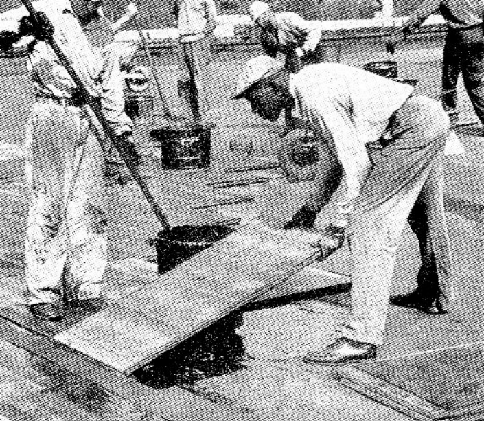
COLOCACION DE LAS PLANCHAS DE FIBERGLAS ROOF INSULATION EN ASFALTO CALIENTE. LAS PIEZAS LARGAS SON PUESTAS CON RAPIDEZ REPASANDOSE LAS JUNTAS.
