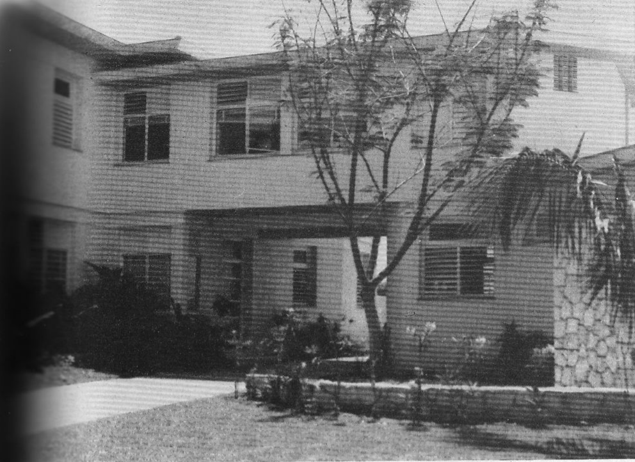
VISTA DE LA ENTRADA DE AUTOMOVILES DE LA RESIDENCIA DEL SR. JOSE RODRIGUEZ.—ANTONIO BOADA SABATES, ARQUITECTO
