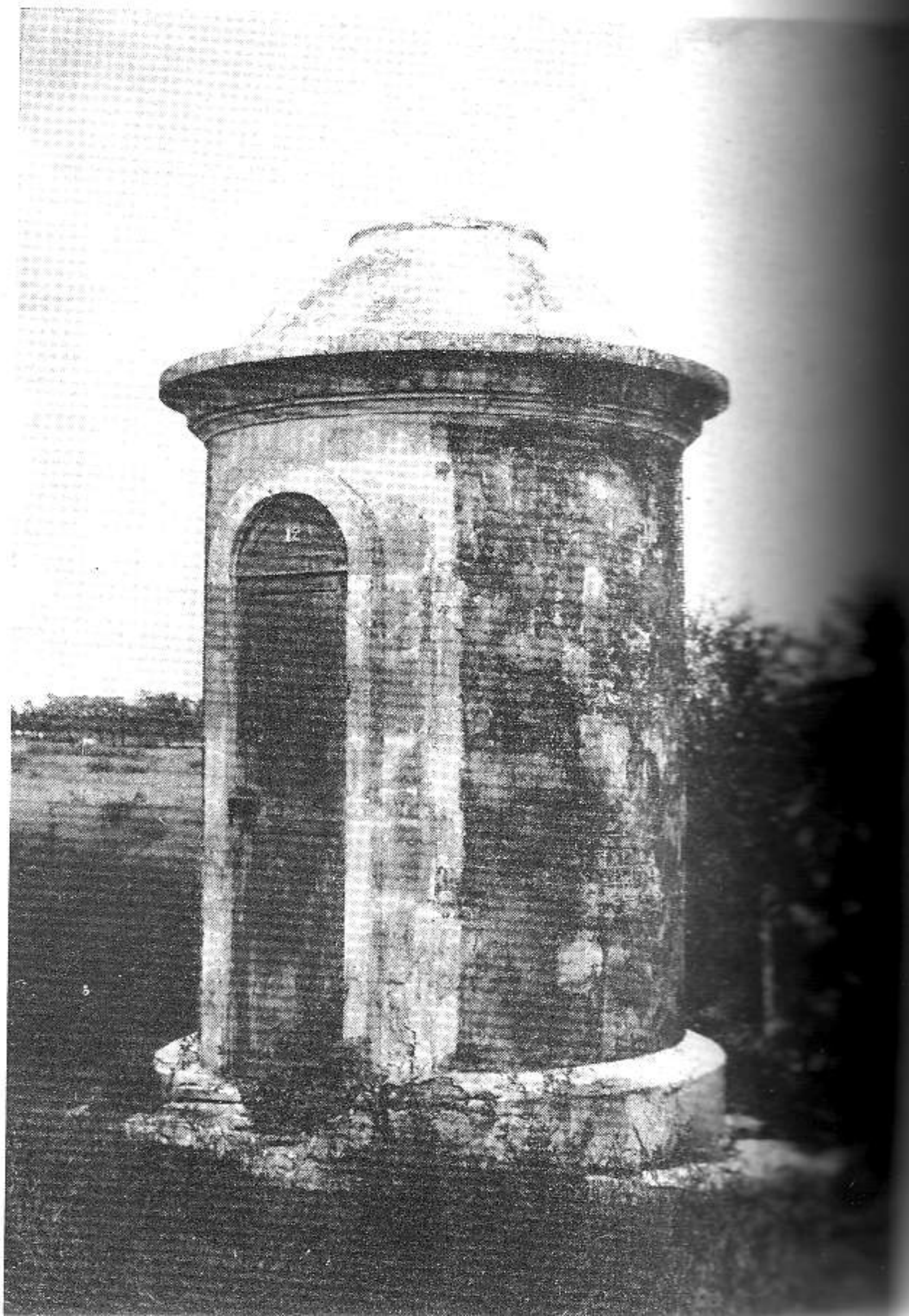
UNA DE LAS VEINTICUATRO TORRES CILINDRICAS QUE EXISTEN A LO LARGO DEL CANAL COMO REGISTROS VENTILADORES.
