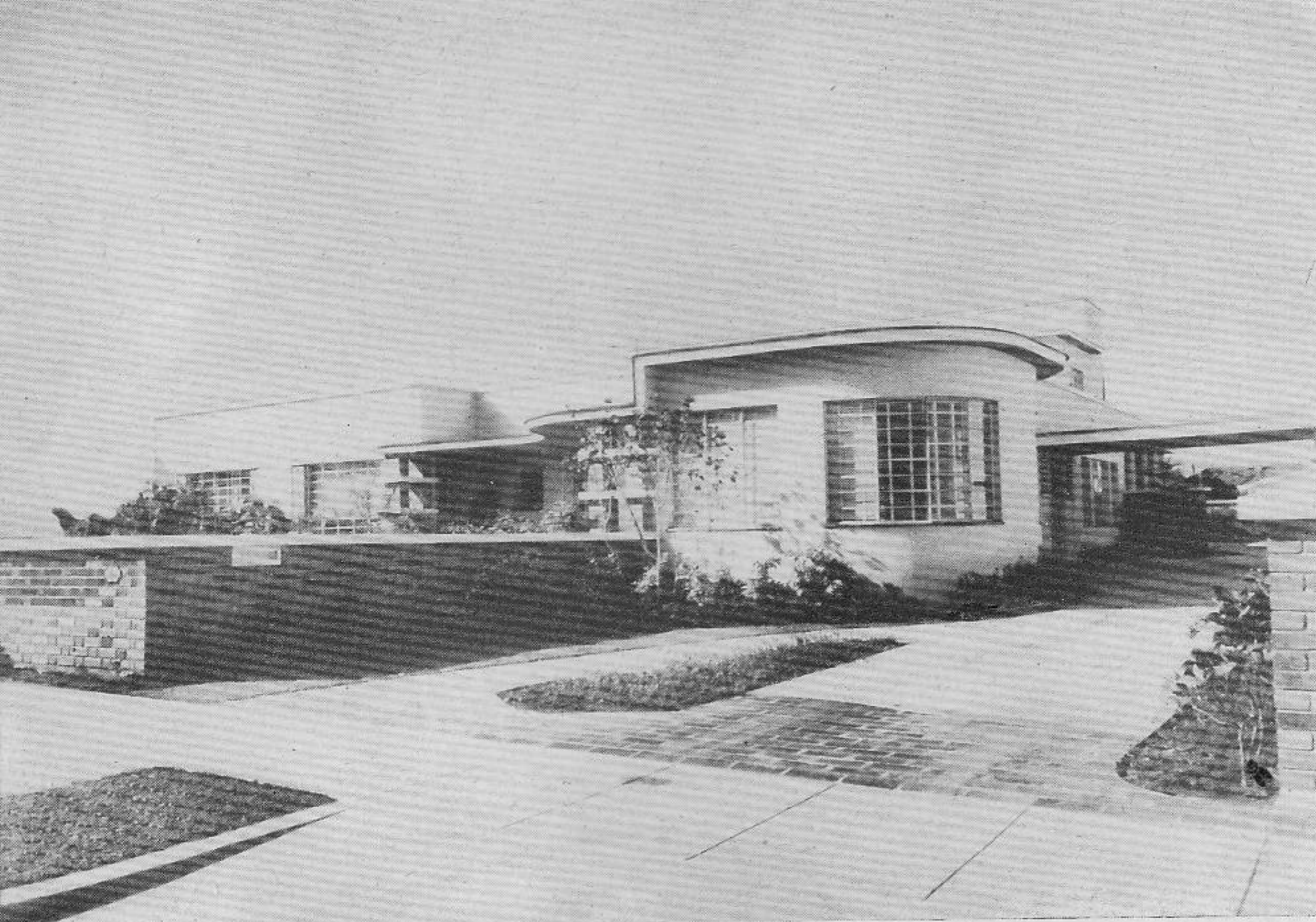
VISTA PERSPECTIVA DE LA RESIDENCIA CONSTRUIDA EN LA CALLE 20, EN EL VEDADO. ELENA V. PUYALS, ARQUITECTA.
