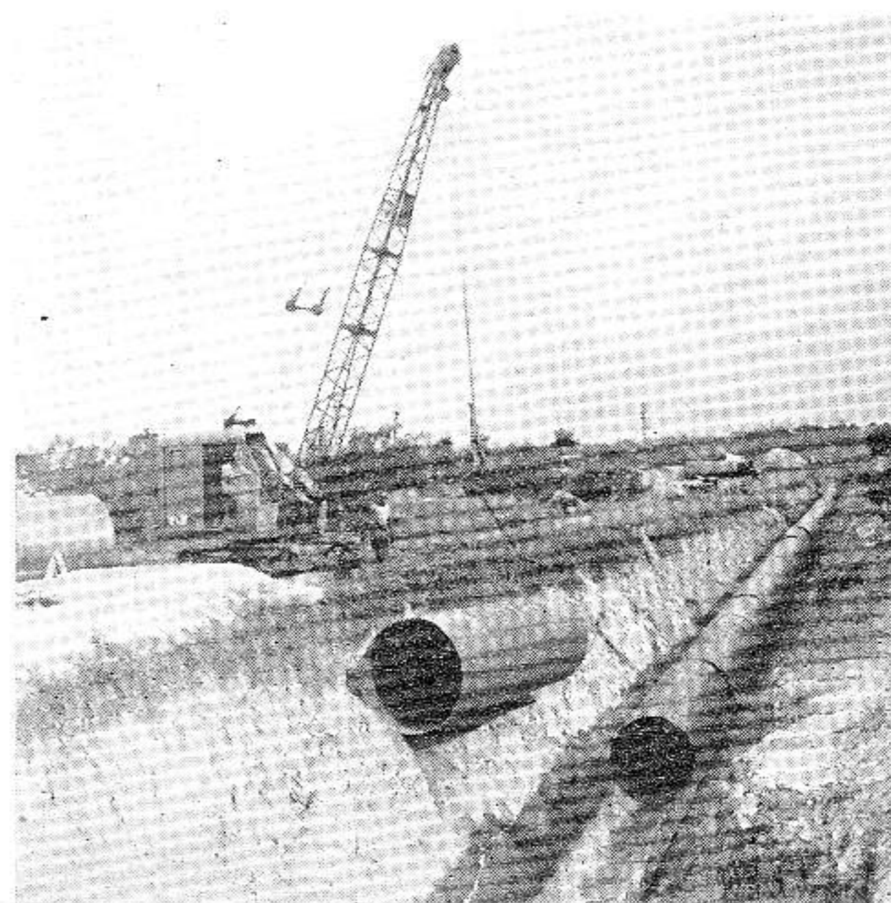
INSTALACION DE LOS TUBOS DE CHAPA DE ACERO SOLDADOS ELECTRICAMENTE SOBRE LAS BASES DE HORMIGON. ABEL FERNANDEZ SIMON, INGENIERO DIRECTOR.
