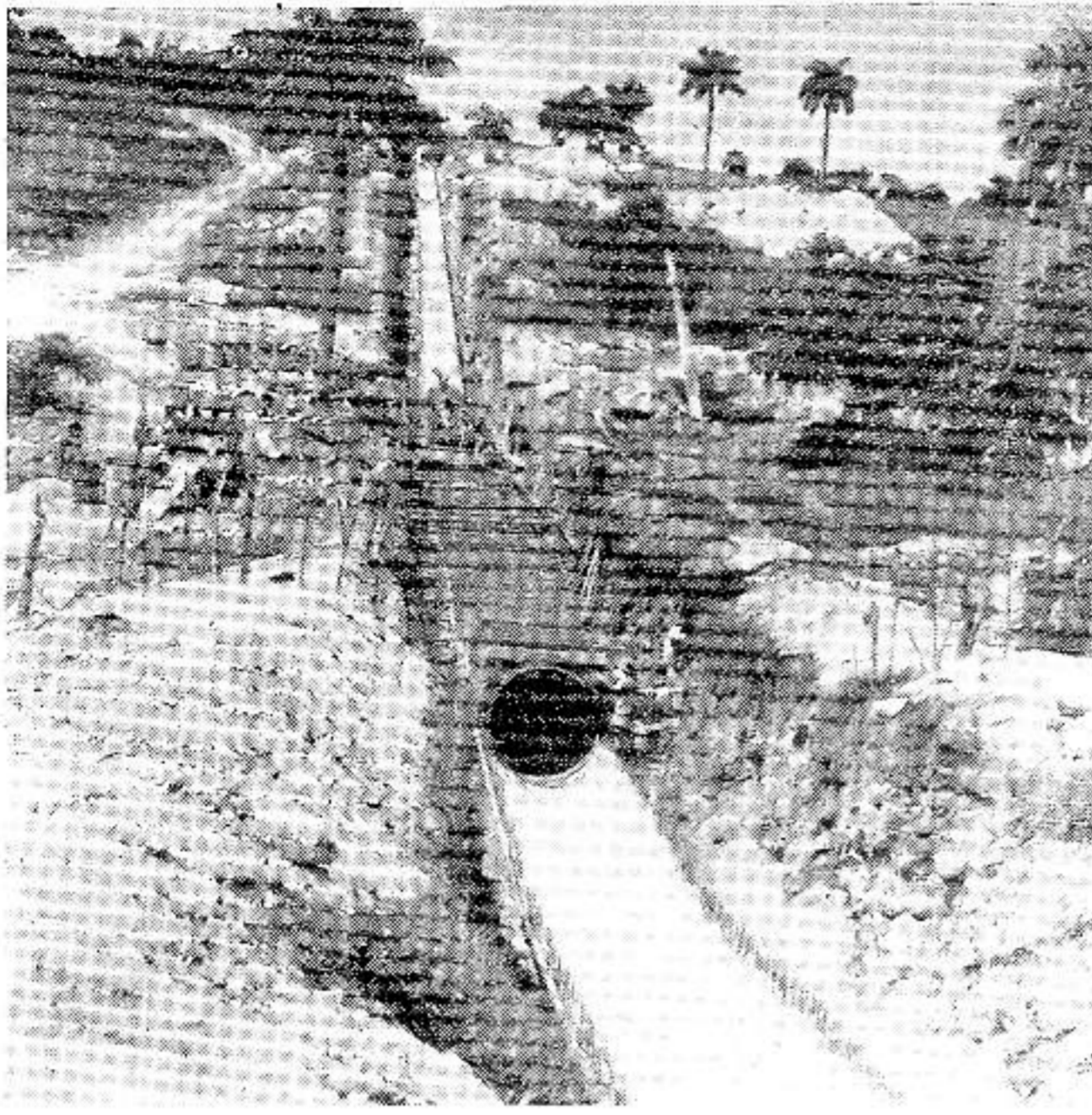
CONSTRUCCION DEL CONDUCTO EN EL FONDO DE UNO DE LOS 18 ARROYOS Y CAÑADAS ATRAVESADAS EN SU TRAZADO.
