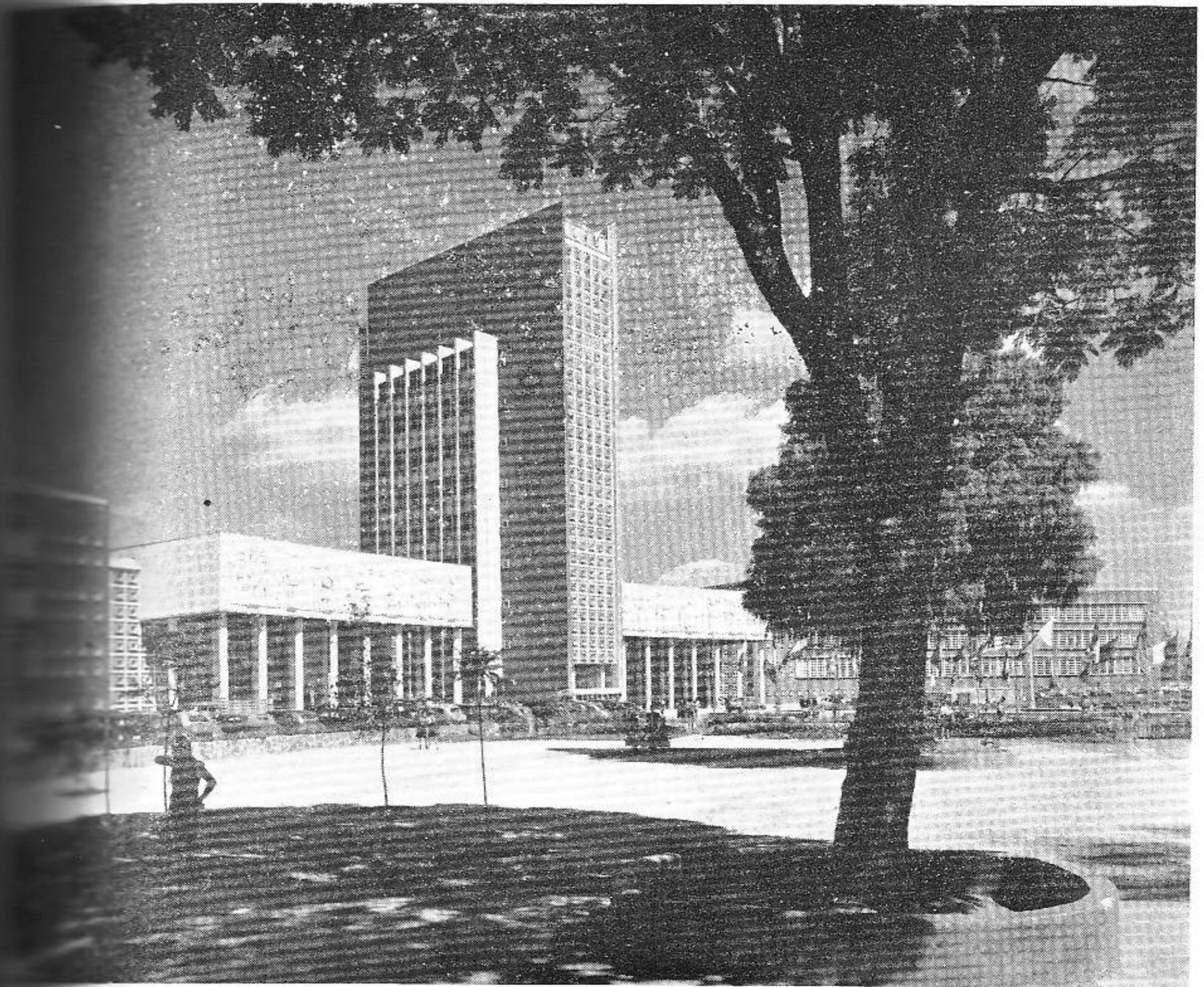
Vista de la parte central del edificio.
