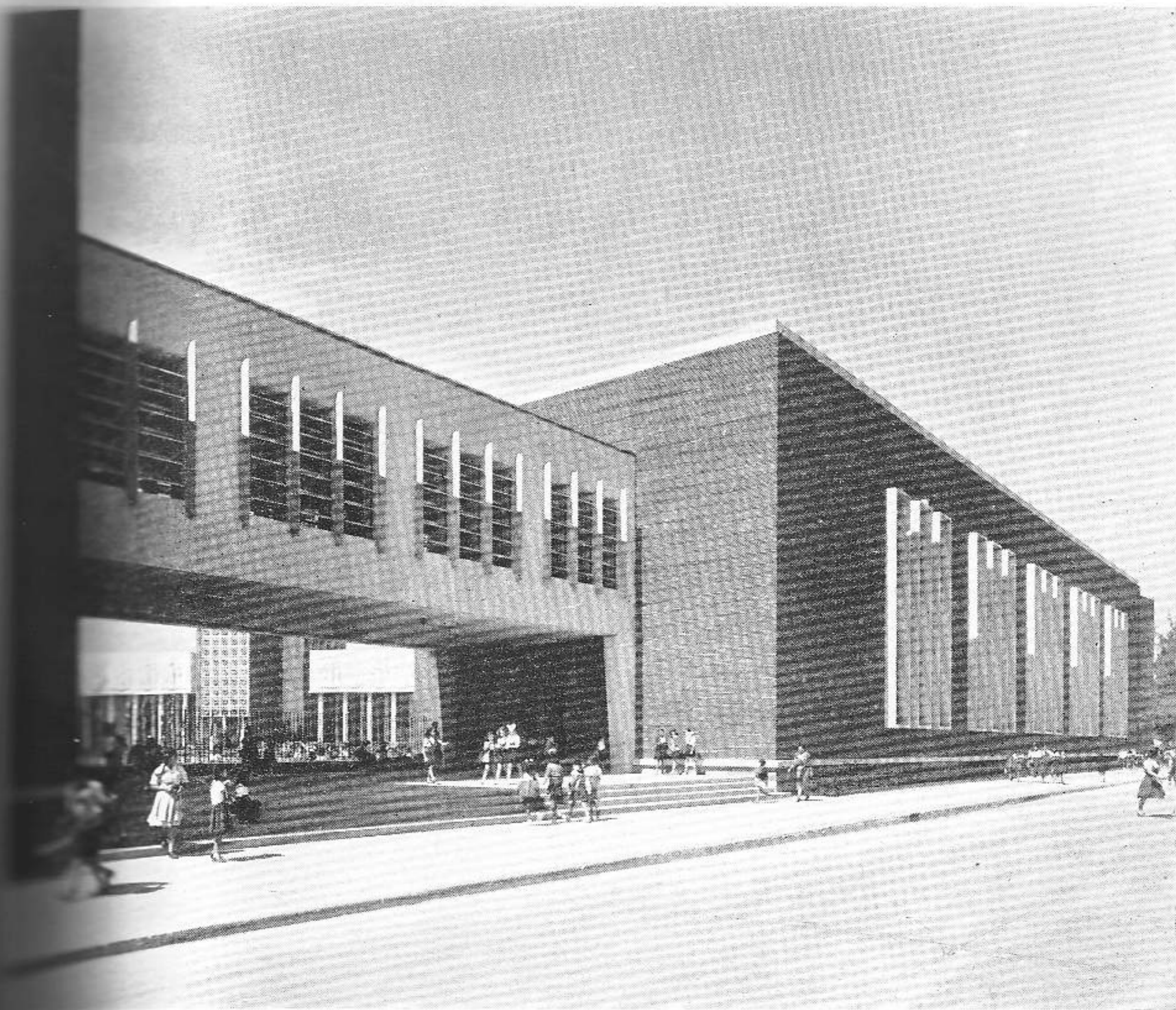
Escuelas Primarias adaptadas, Fachada exterior.
