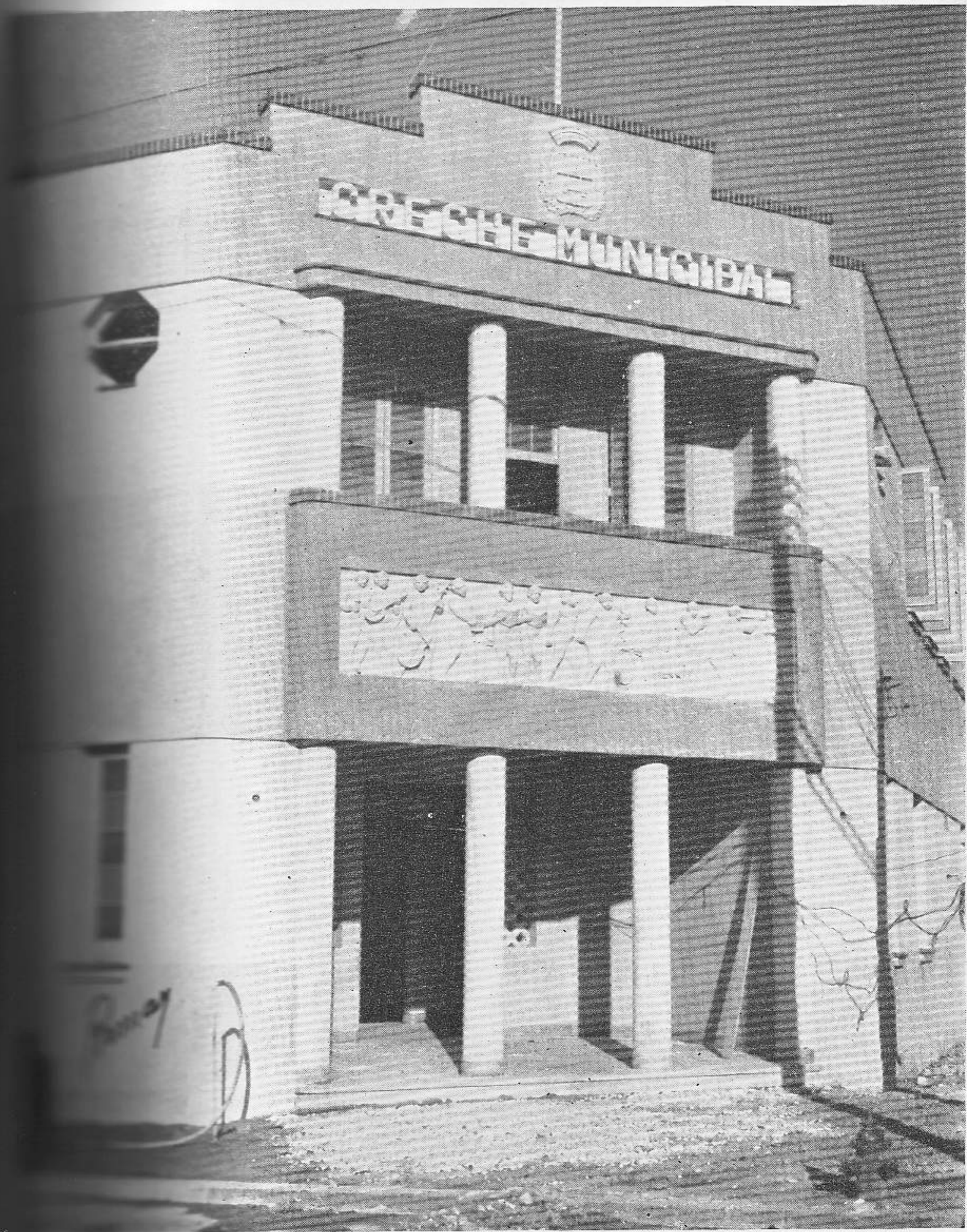
Detalle de la fachada de la Creche Modelo. Arquitecto: Manuel Febles Valdés.
