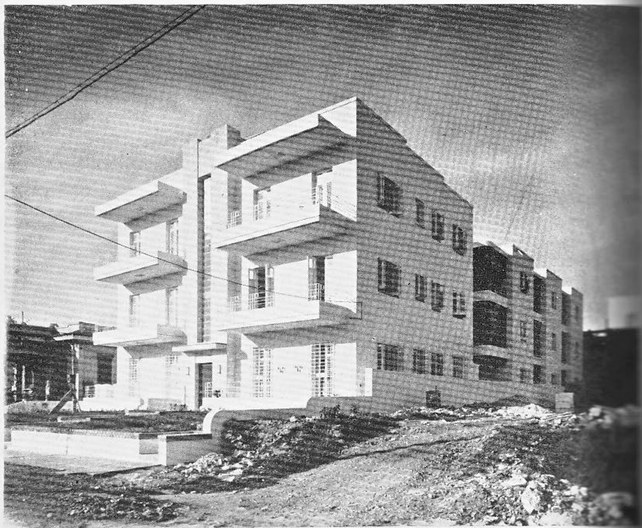
Edificio de Apartamentos situado en la calle 26 entre 21 y 23. Arquitecto Proyectista: Armando Paredes. Arquitectos Constructores: García Meitin, Gómez Millet, Puentes y Corrales.
