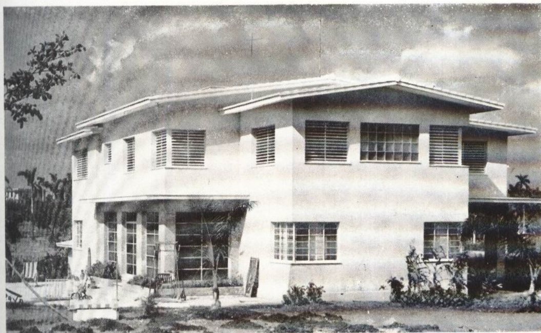
Residencia del Arq. Eloy de Castroverde. Reparto Biltmore. Morales y Castroverde, arquitectos.
