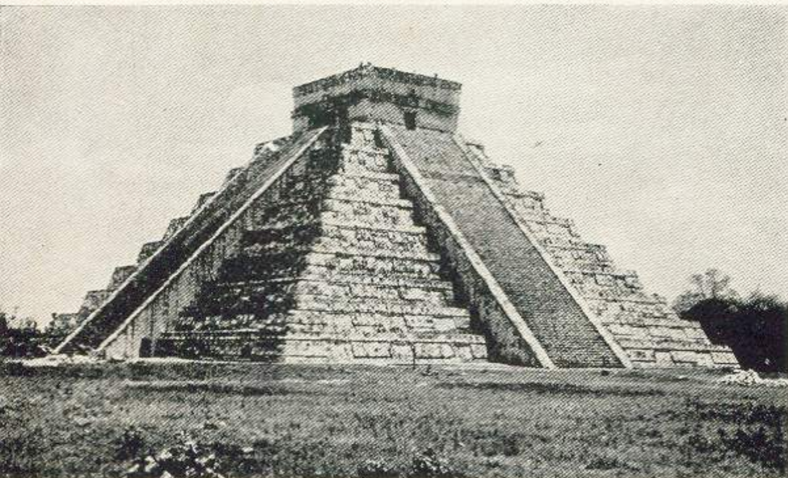
"El Castillo" de Chichen Itzá, el más alto de los edificios Mayas, unos 30 metros, con graderías altas y estrechas para alcanzar una construcción superior que se dice era la morada de "Kukulcán"; pertenece al Nuevo Imperio y ya tiene el techo plano.
