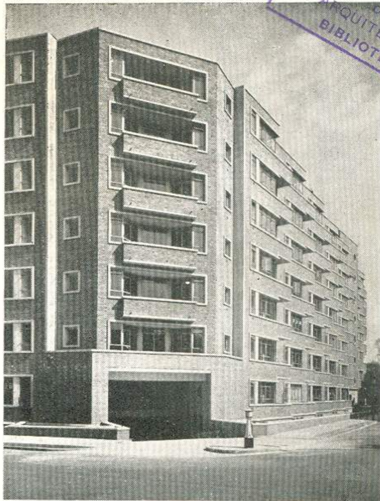
Edificio de departamentos situado en Oslo Court, Londres. Los ventanales de cada balcón se han diseñado de manera que cada pieza disfrute del máximo de luz y aire.
