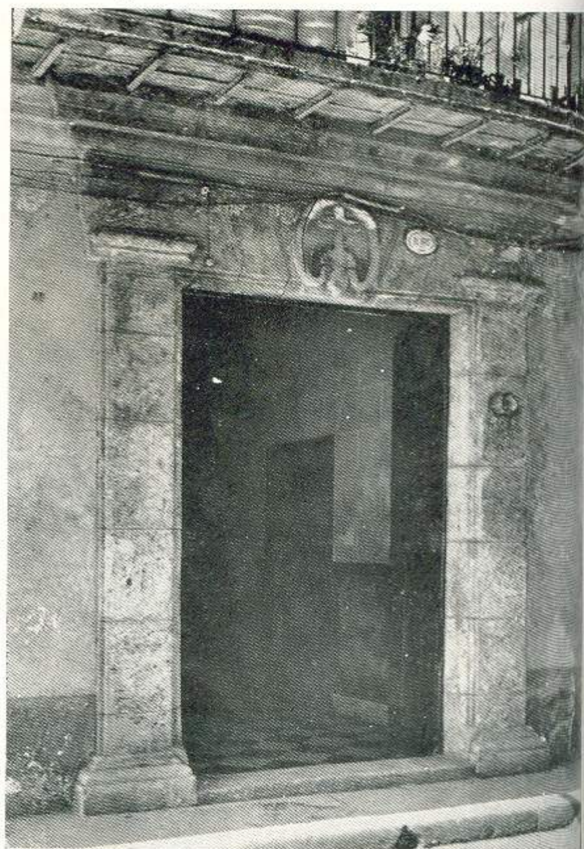
Edificio situado en la calle de los Oficios número 2, que fué el primer Palacio Episcopal que tuvo La Habana.
