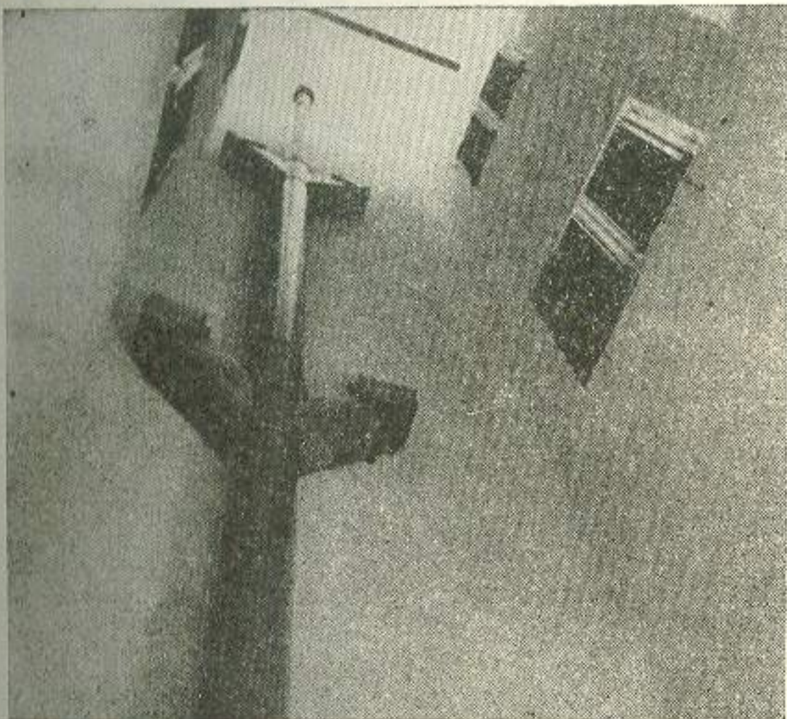
Detalle de los receptores para basura, automáticos, instalados por la importante firma industrial Amaro Blanco.
