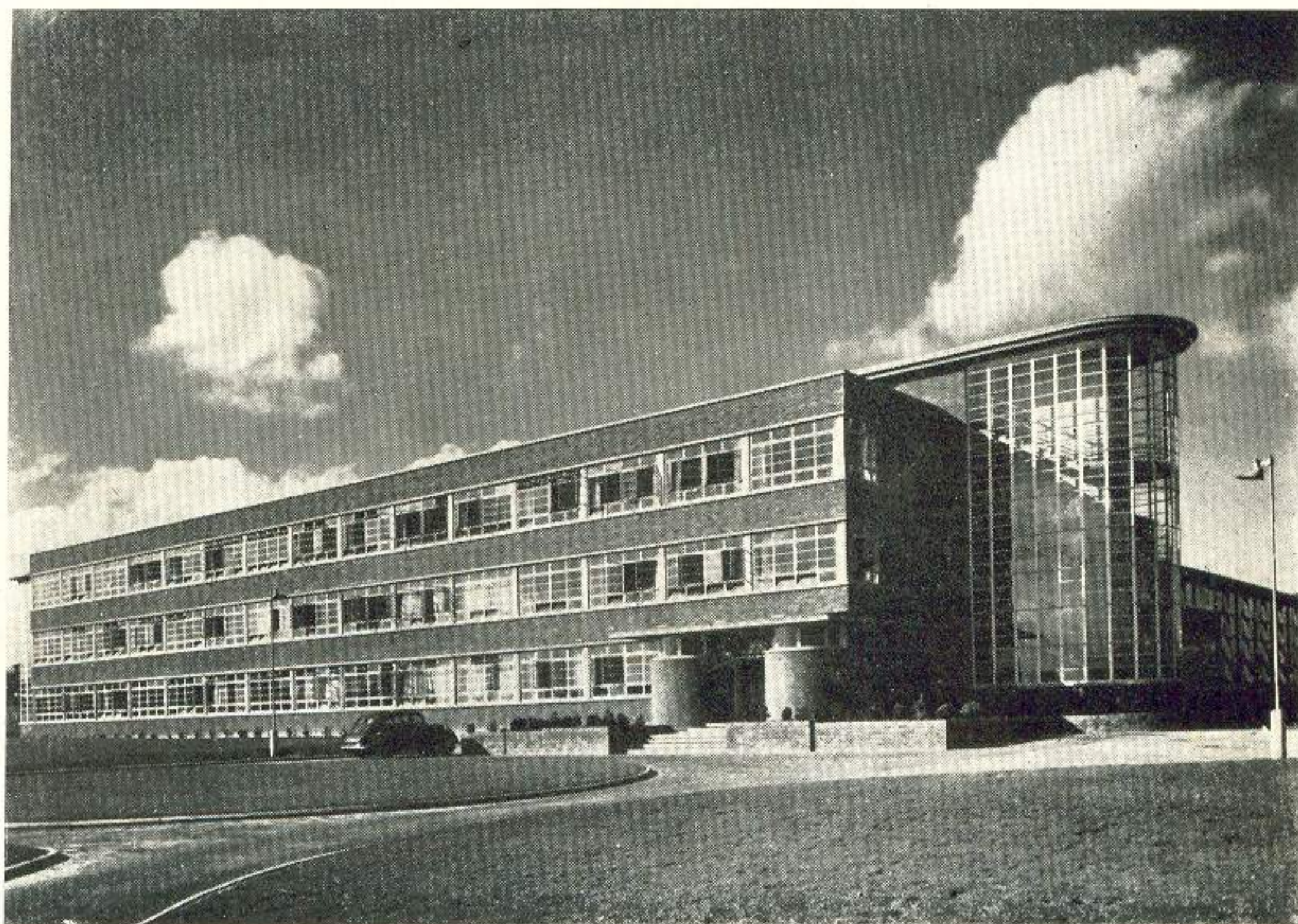
Tipo de una construcción escolar moderna situada en el condado de Kent.
