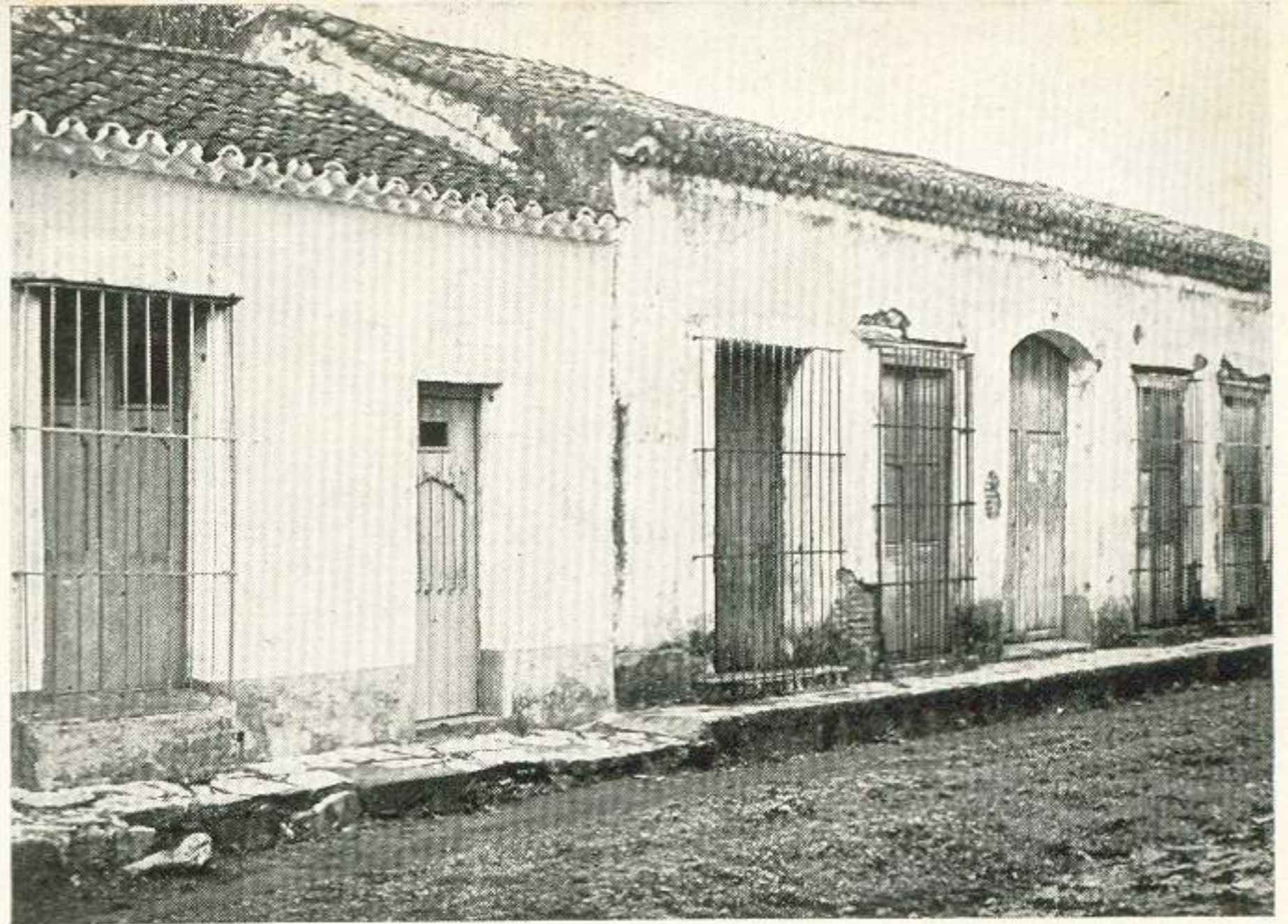
Dos casas centenarias de la calle de Lamar en una de las cuales nació nuestro colega el arquitecto Juan M. Lagomasino.
