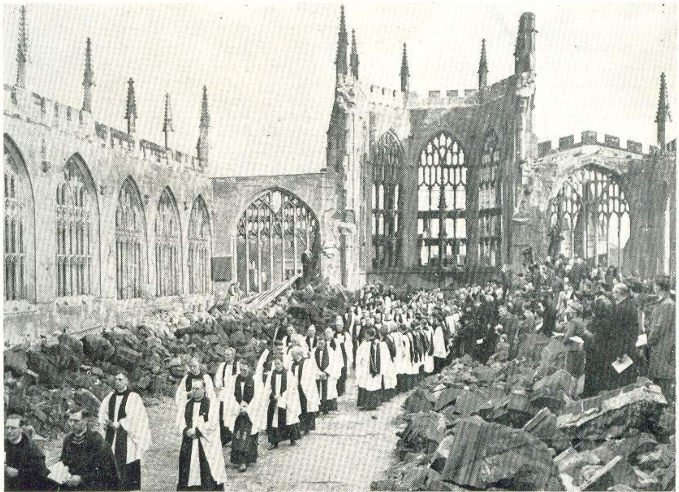
Ruinas de lo que fuera la bellísima Catedral de Coventry, joya de la arquitectura inglesa, construcción que data del siglo XII. Este magnífico templo, de estilo gótico, fue casi totalmente destruido por las bombas incendiarias que arrojó sobre ella la Luftwaffe alemana.
