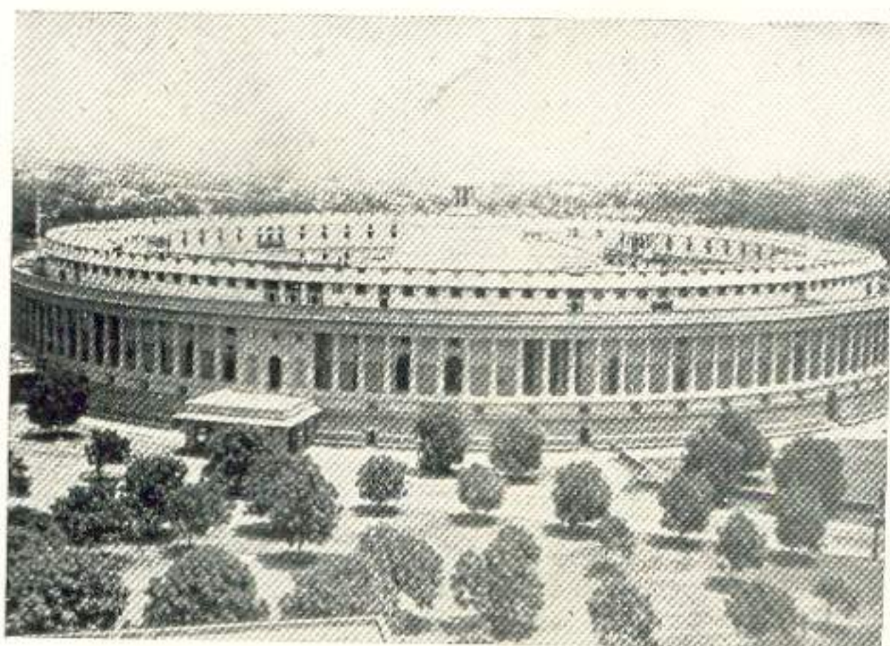
Edificio del Gobierno de New Delhi. Arquitecto Sir Edwin Lutyens.
