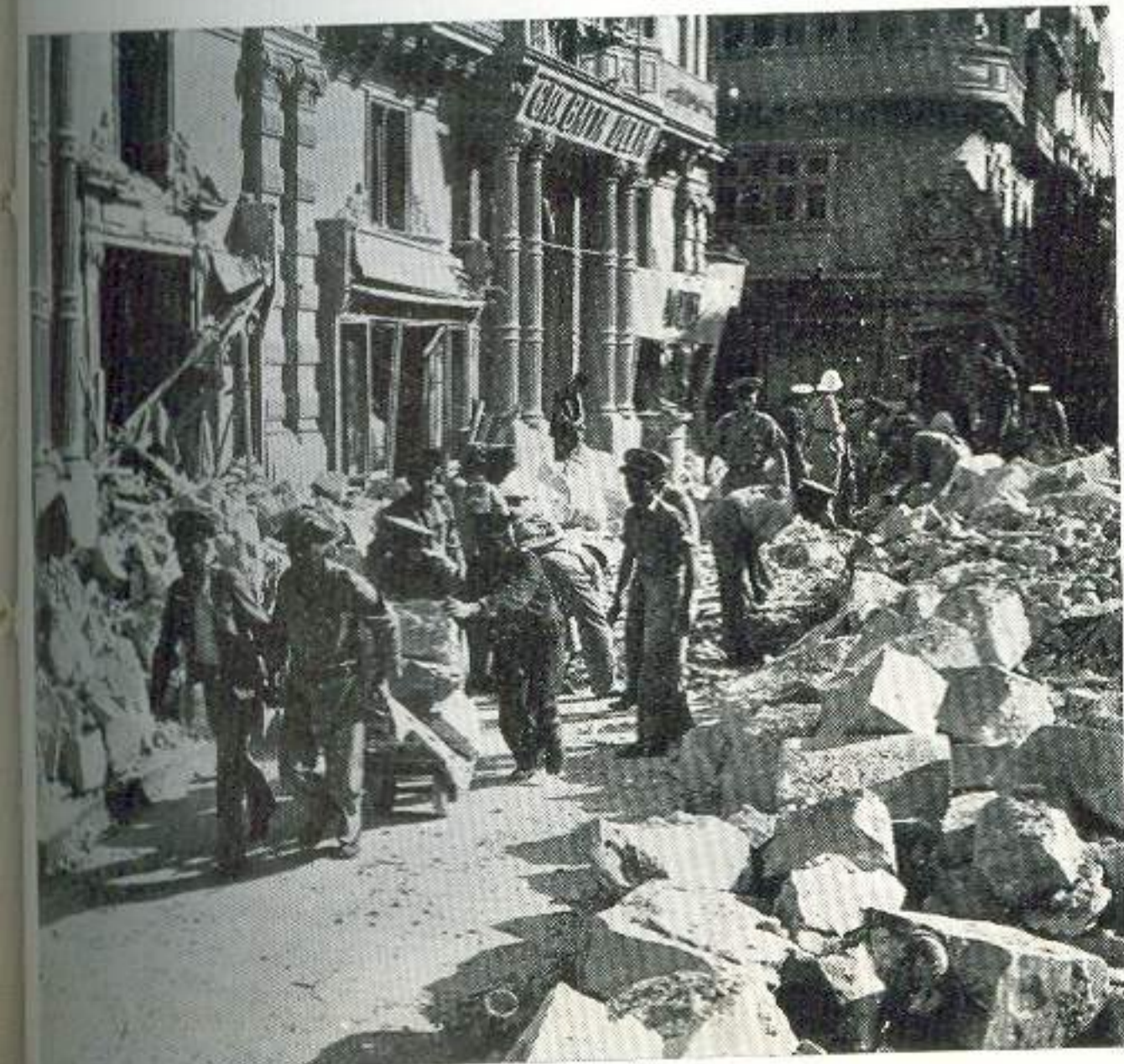
El Teatro de la Opera aparece semi destruido por la explosión de una bomba de gran potencia destructiva. Se ven las cuadrillas de salvamento limpiando de escombros la calle, después del ataque por los aires.
