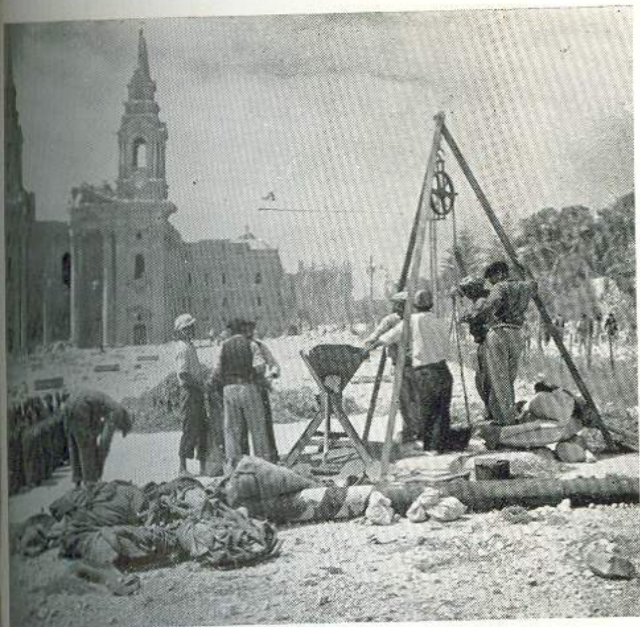
Trabajo de la iglesia de San Pablo. En primer término, voluntarios malteses extrayendo de los graneros subterráneos, sacos de trigos y cereales, para el alimento de la población.
