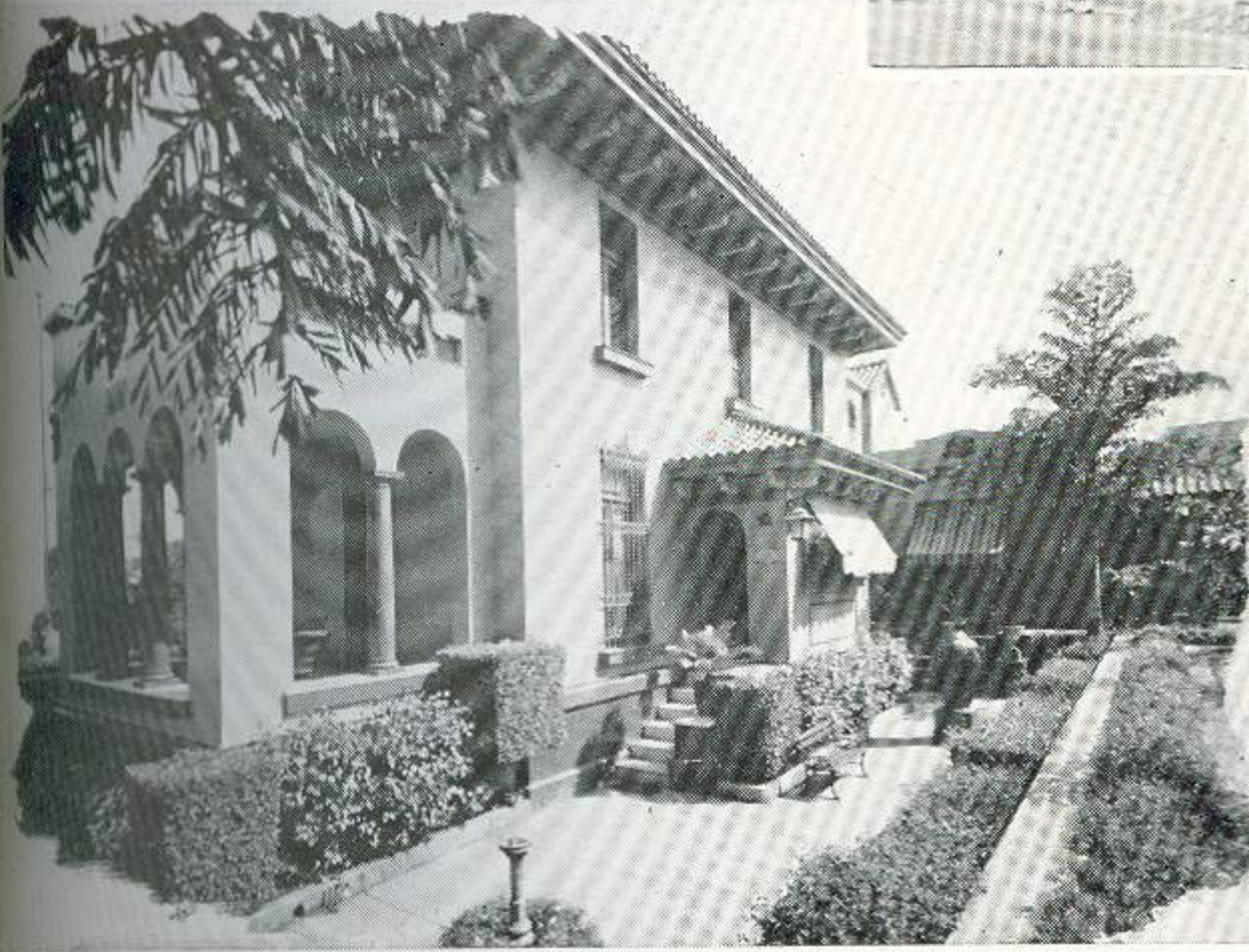
Residencia, en el Reparto Almendares, del arquitecto Luis Echeverría.
