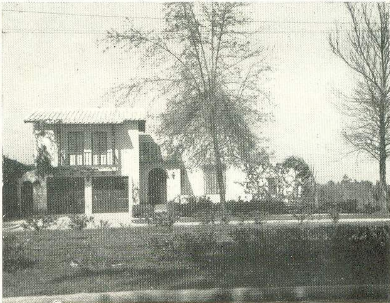
Residencia de la Sra. Mercedes Pujol de Oliver, Reparto Miramar. Fernando R. de Castro, arquitecto.
