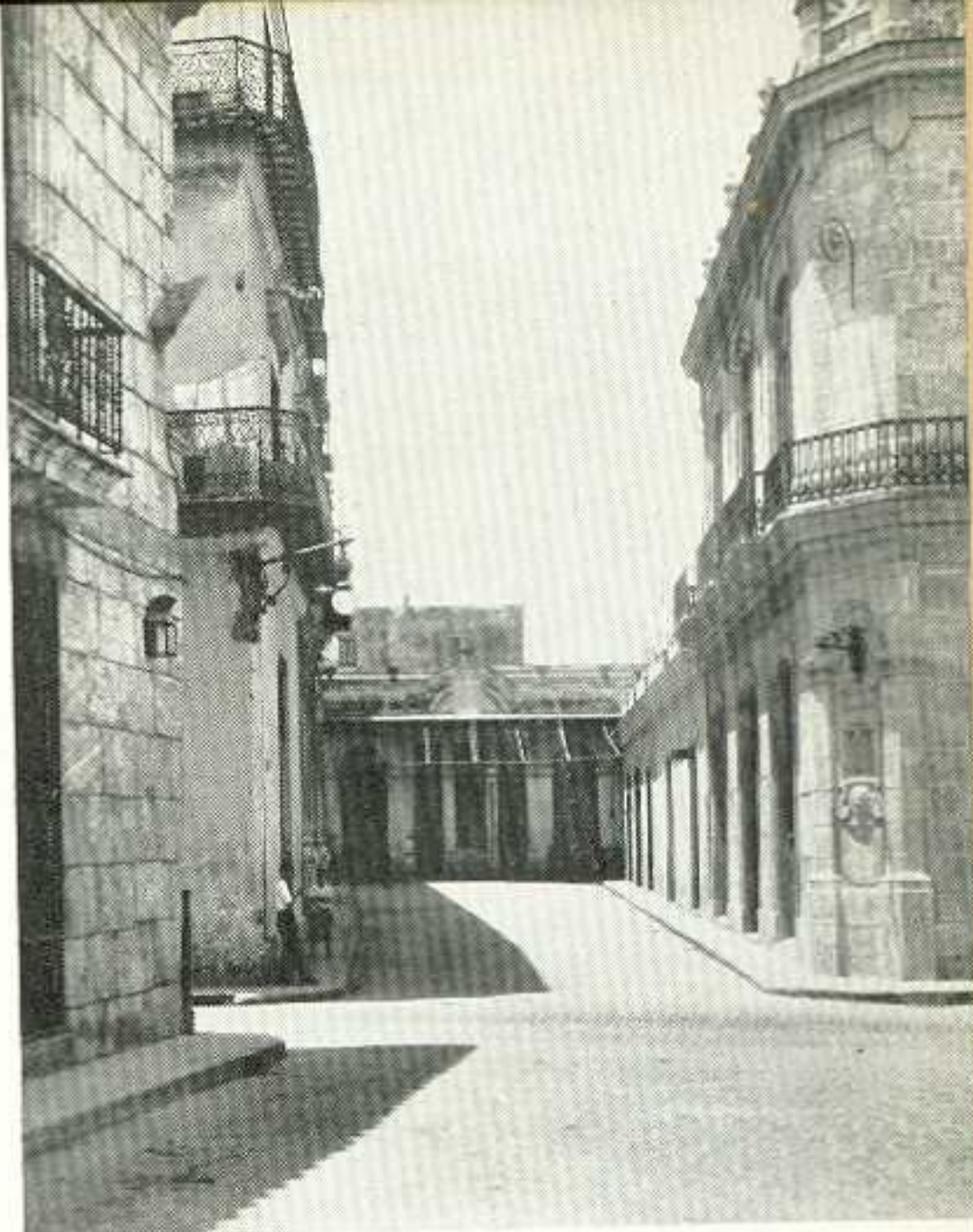
El Callejón del Chorro. Al fondo la casa, mostrando la altura en que estaba la lápida, las planchas de zinc a manera de marquesina y la armazón de tubos para toldos de lona que impide ver la lápida.
