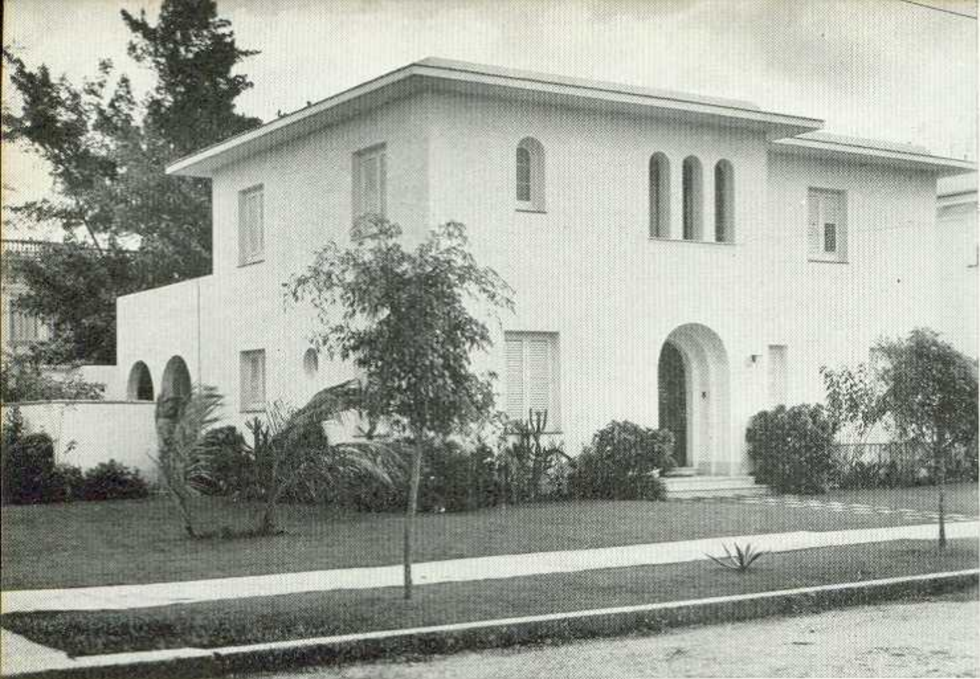
Residencia del Sr. Joaquín Boada, calle 12 y 3a., Reparto Miramar, Antonio Boada, arquitecto.
