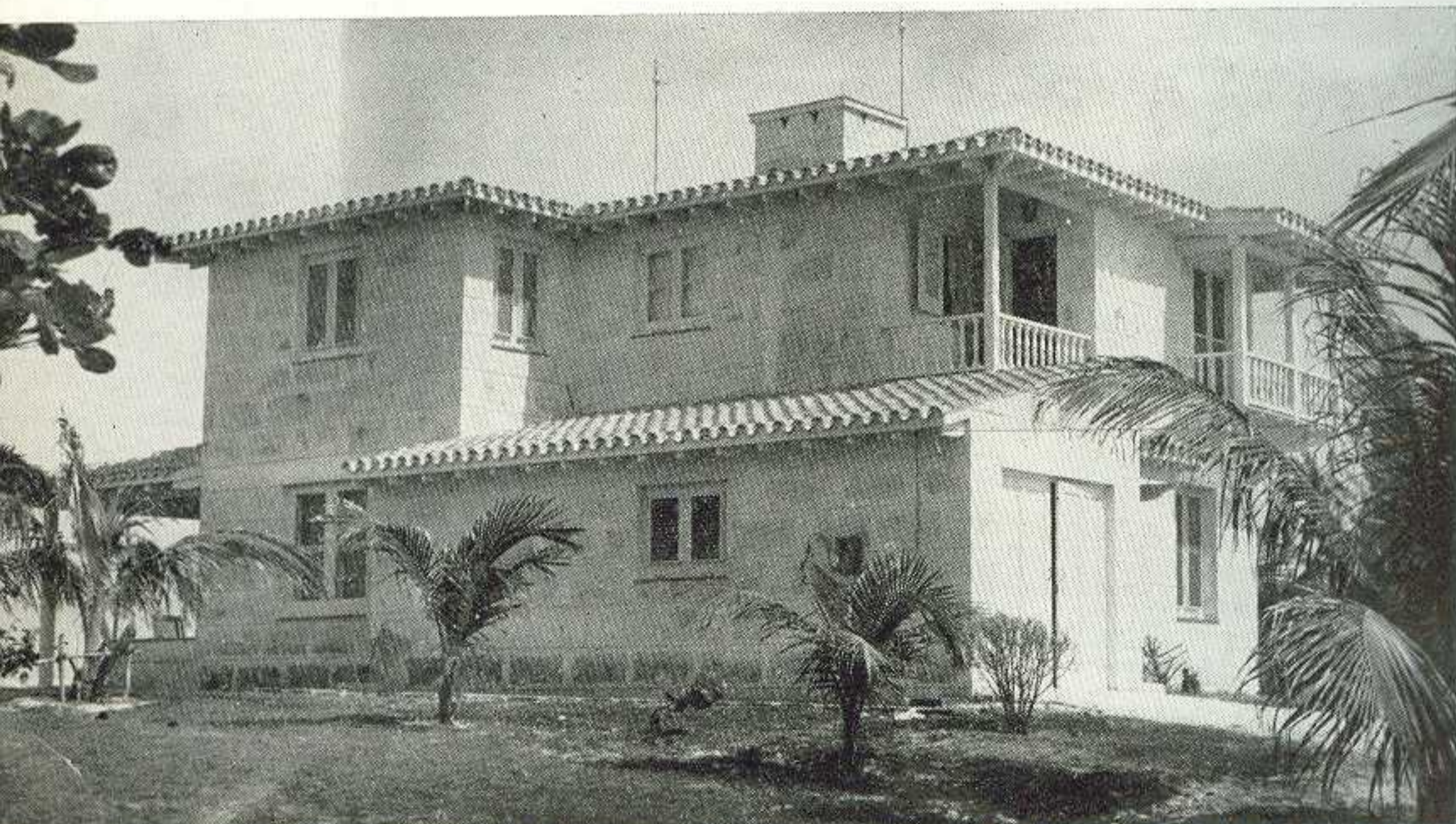
Residencia del General José Martí, Varadero, M. A. Gonzalez del Valle, arquitecto.
