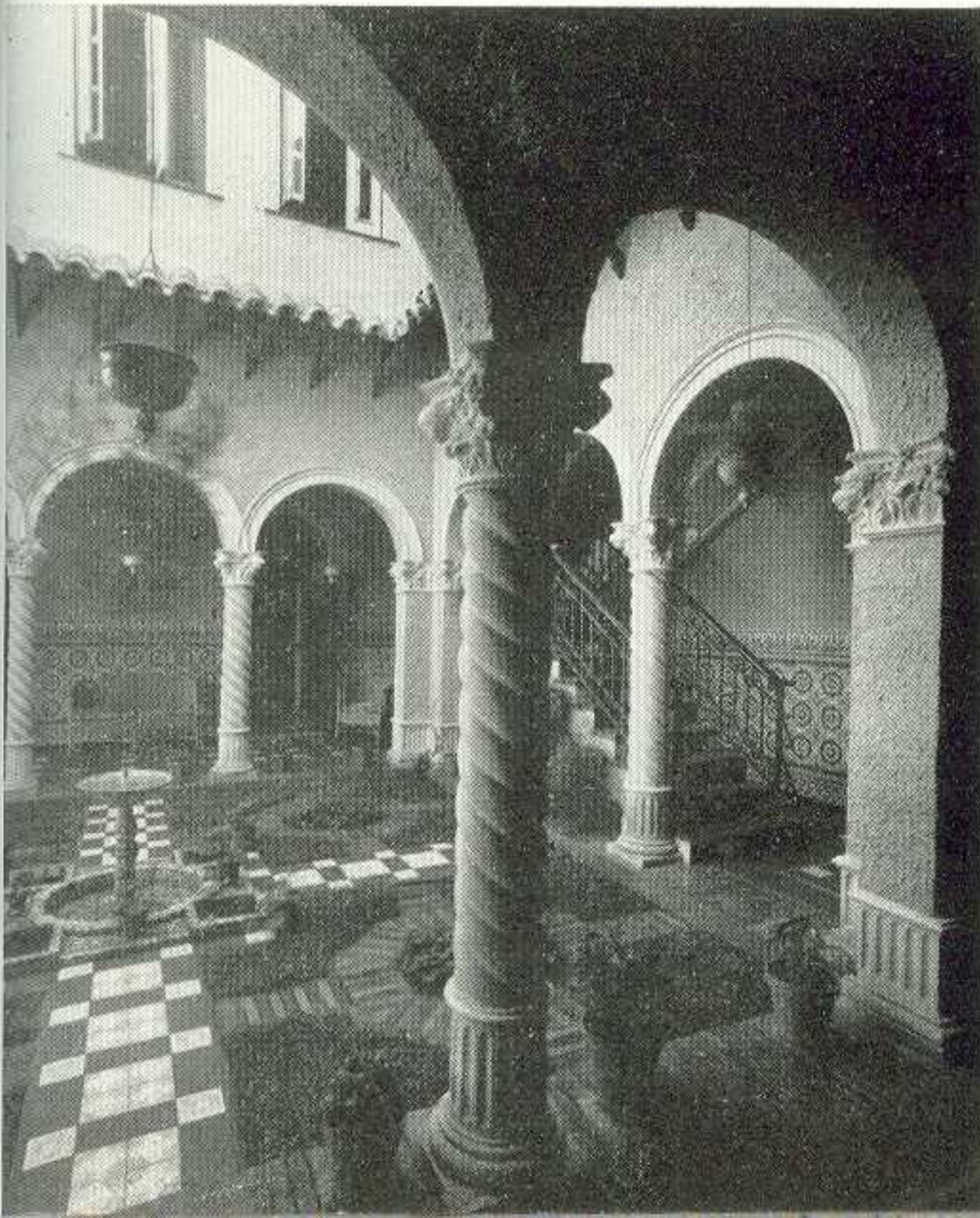
Residencia del Sr. Fabian Urrutiabascoa. Alturas de Miramar. Patio, Ri- cardo Mira, arquitecto.
