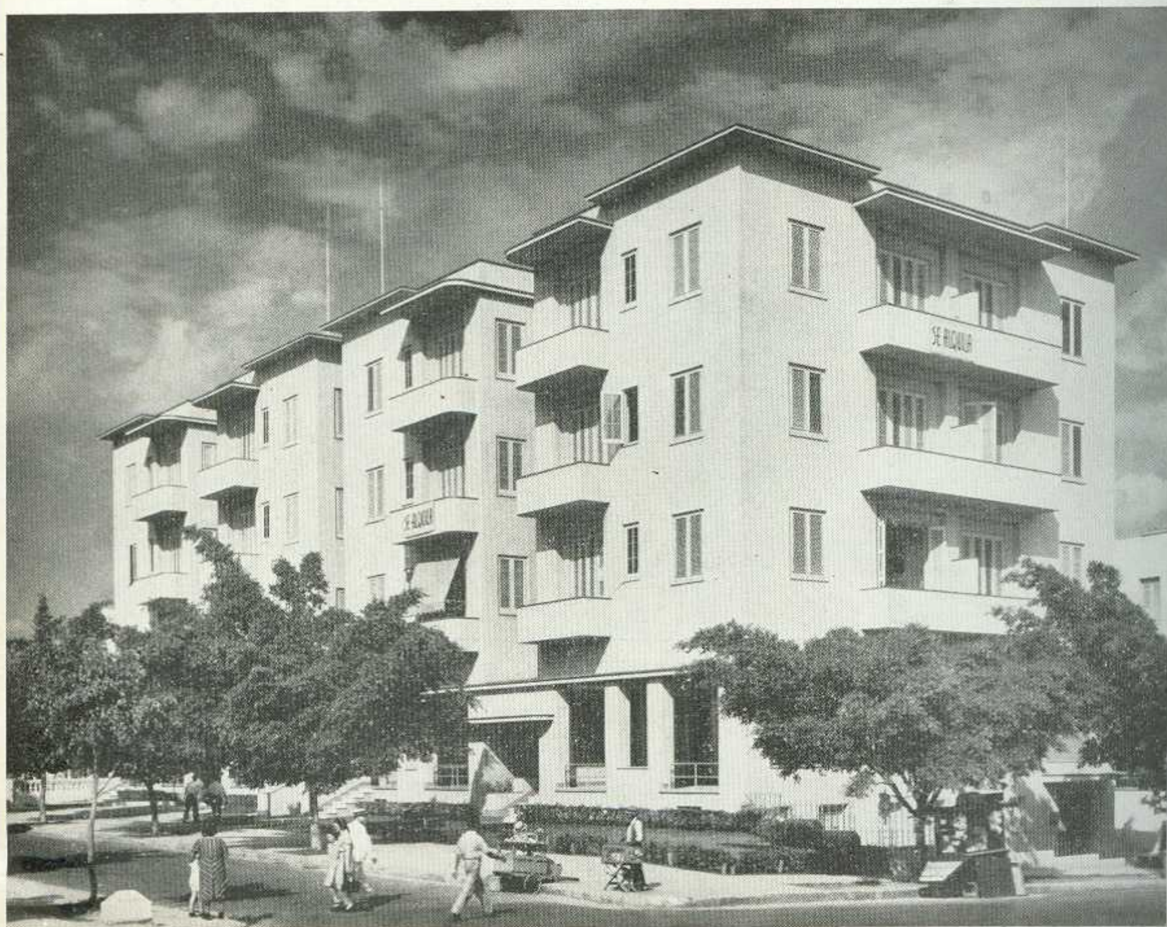
Casa de Apartamentos 27 esq. a G. Vedado. Rafael de Cardenas, arquitecto.
