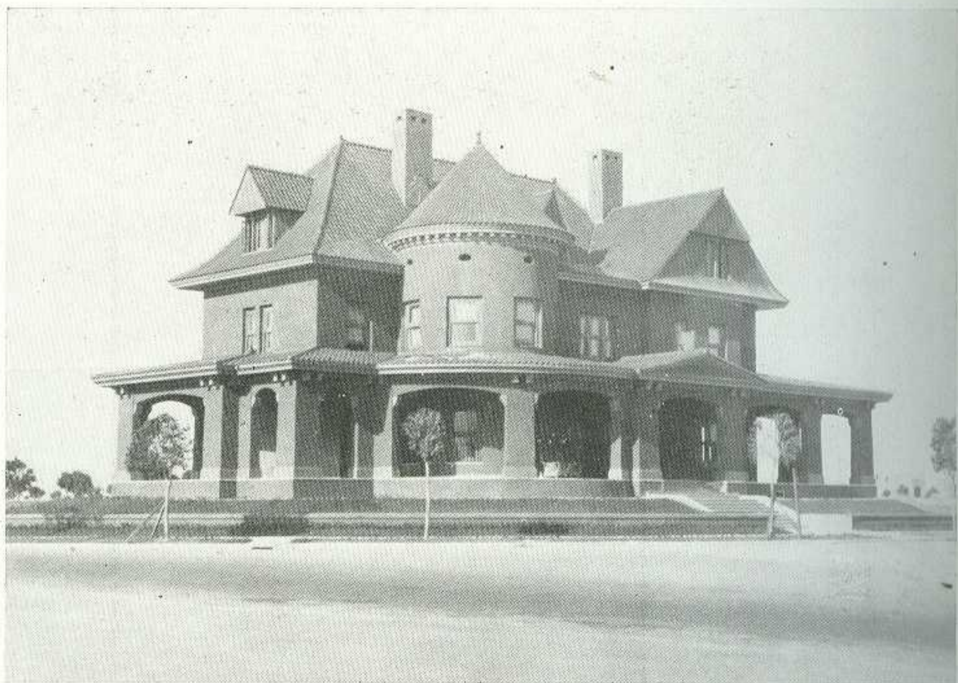
Residencia del Sr. Alberto de Armas, 5a. Avenida esq. a 2, Reparto Miramar, arquitecto Jorge Luis Echarte.
