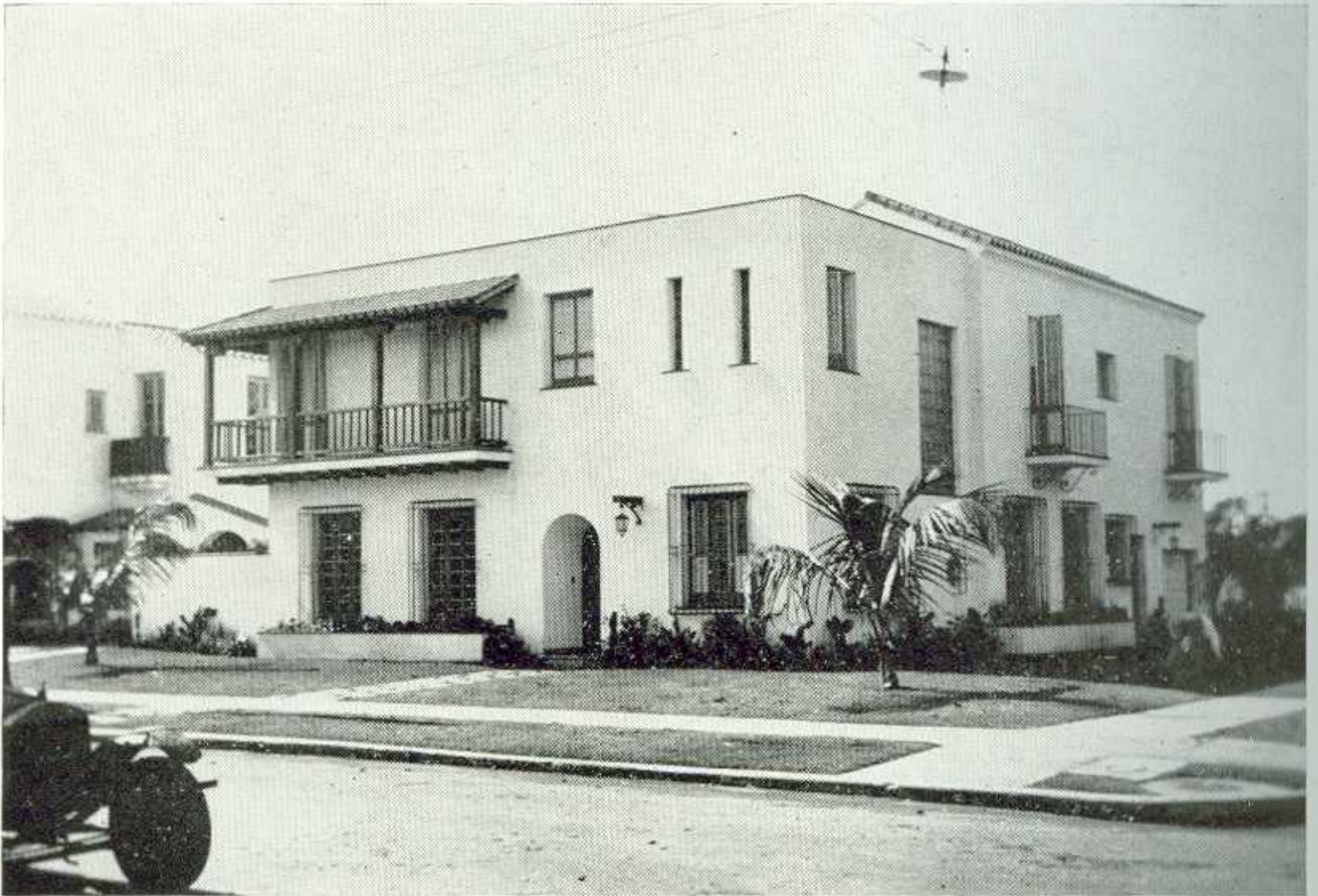
Residencia del Dr. Alfredo Loret de Mola, 34 y 3a. Av. Miramar, Morales y Castroverde, arquitectos.
