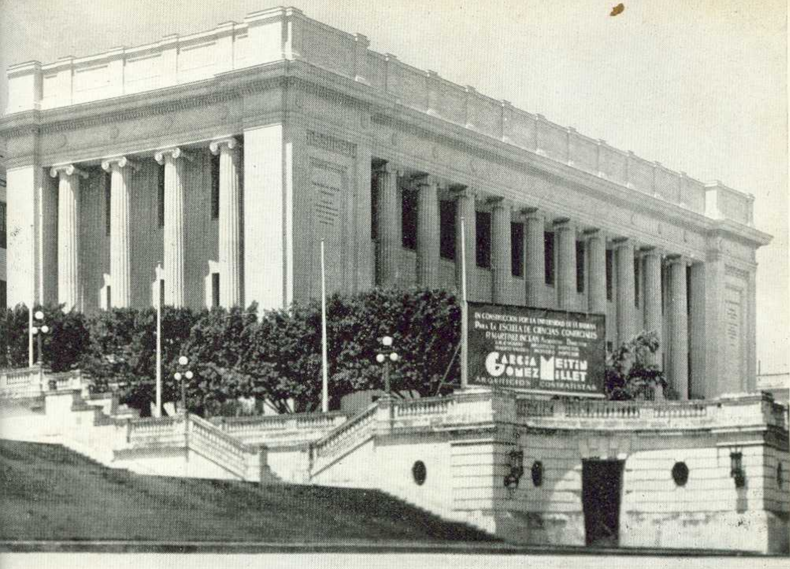
Edificio de la Escuela de Ciencias Comerciales, Universidad Nacional. Proyecto del arquitecto Pedro Martínez Inclán; arquitectos García Meitín y Gómez Millet, contratistas.
