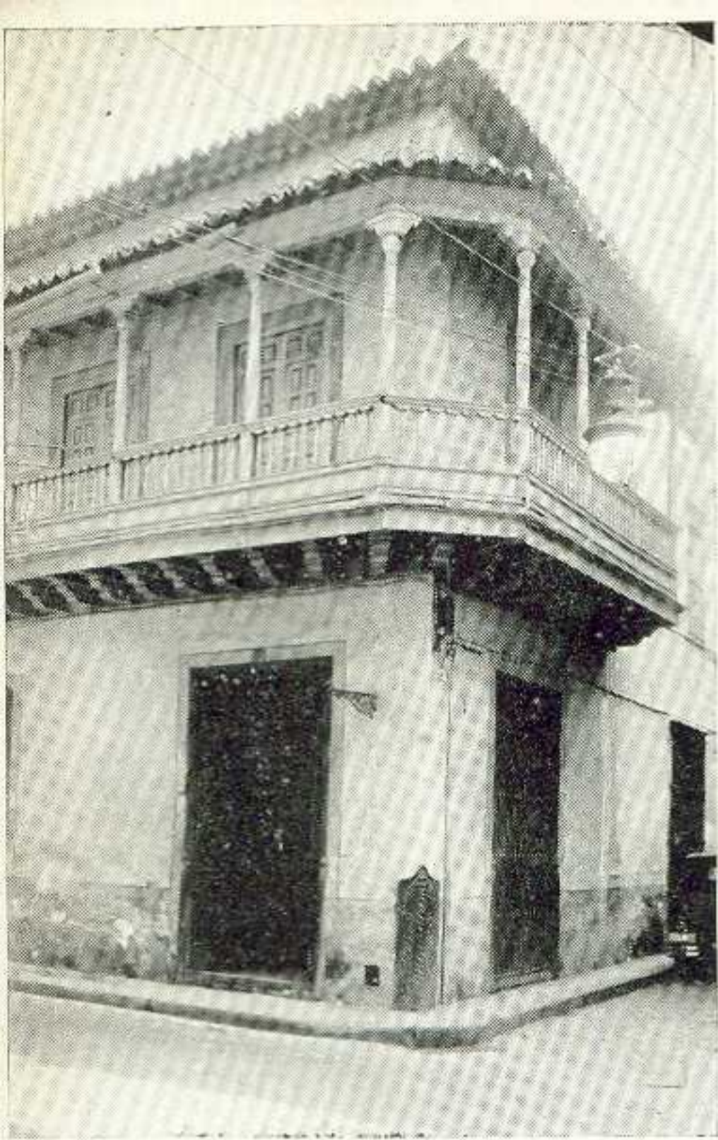
Residencia situada en Teniente Rey y Aguiar, mostrando el doble tejado.
