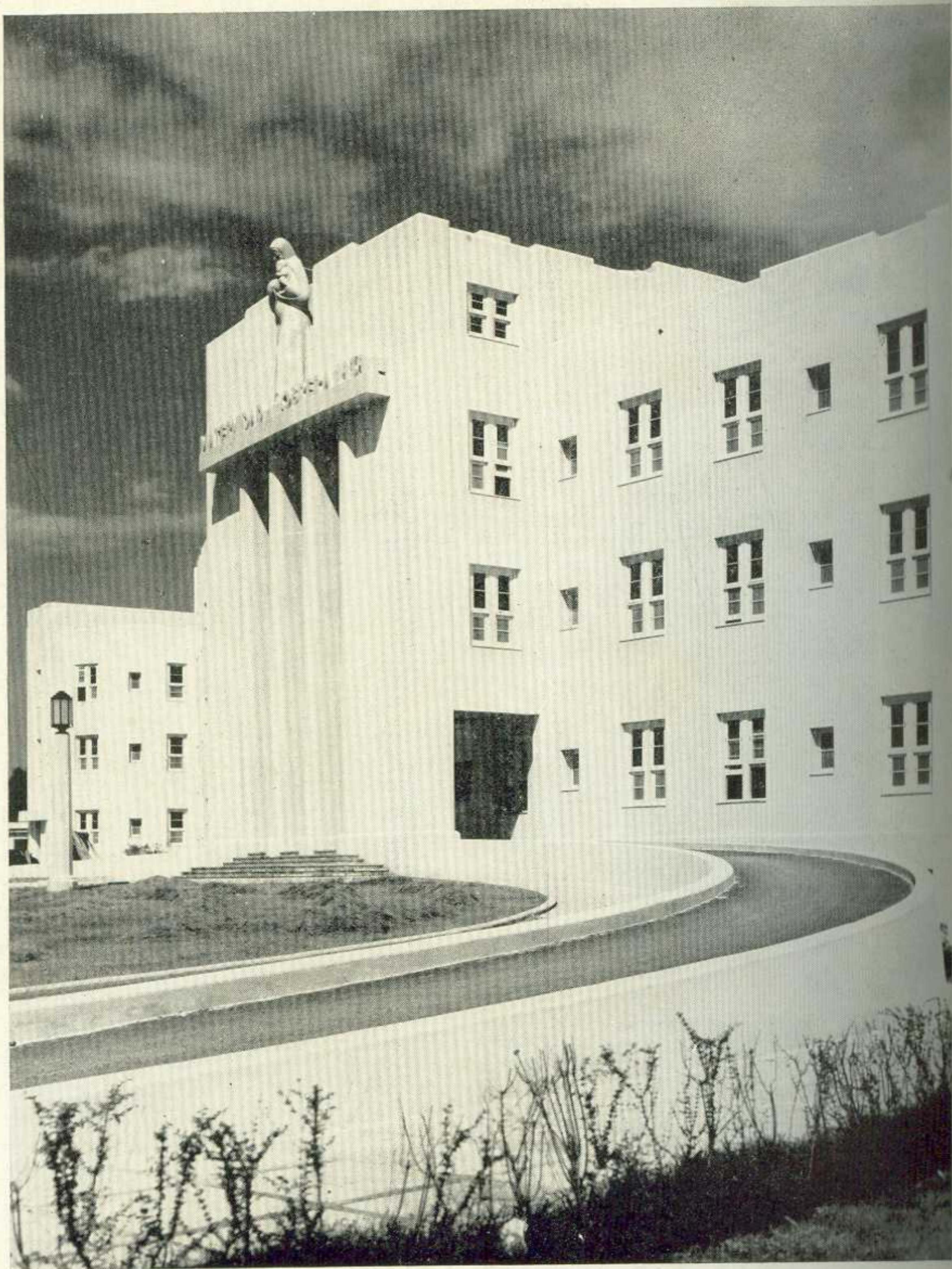
Detalle del cuerpo Central de la fachada principal del Hospital de Maternidad Obrera. Emilio de Soto, arquitecto.
