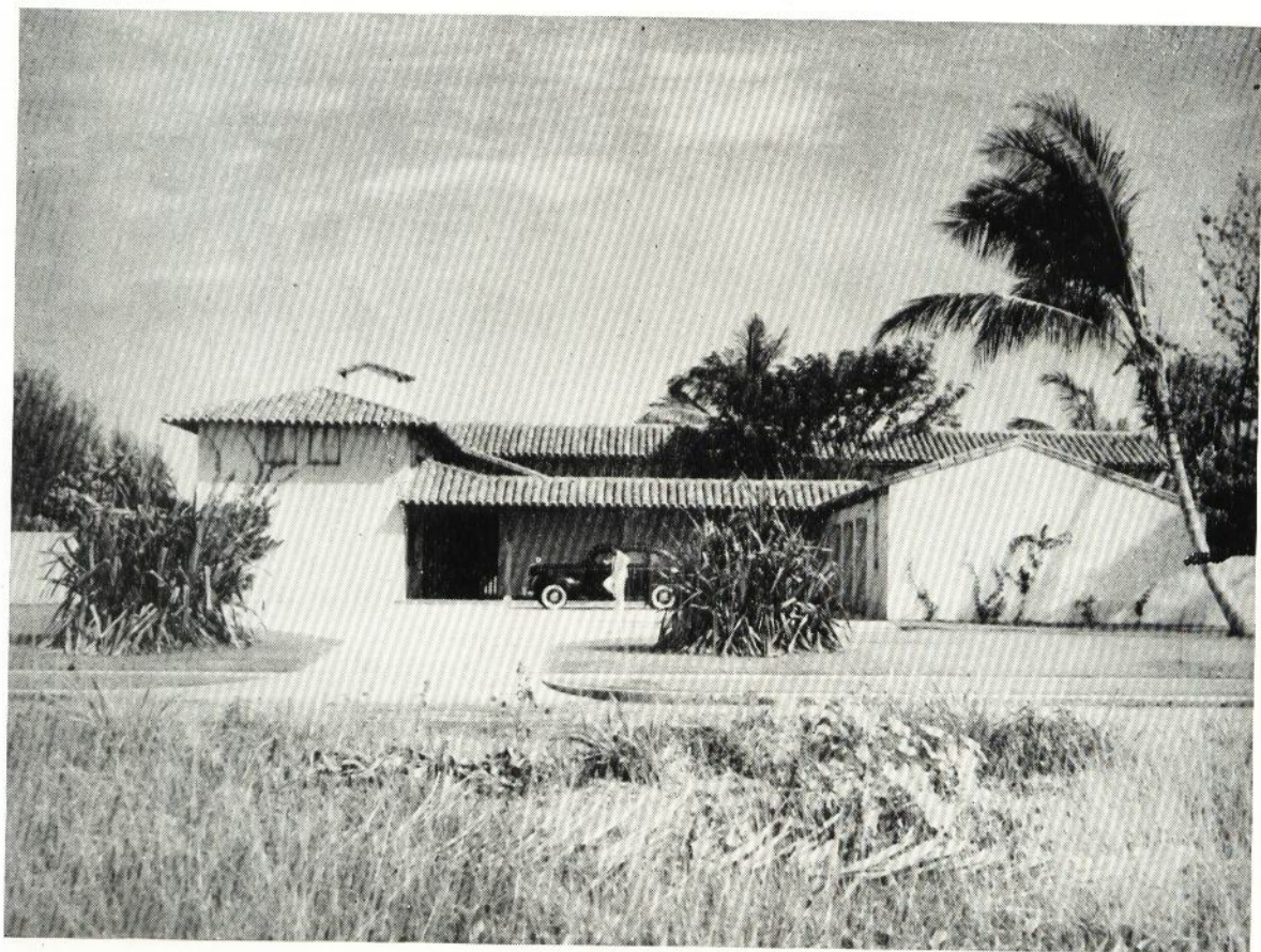
Residencia del señor Eutimio Falla en 1ª Avenida y calle 28, Reparto Miramar, que obtuvo el Segundo lugar, Ernesto y Eugenio Batista, arquitectos.
