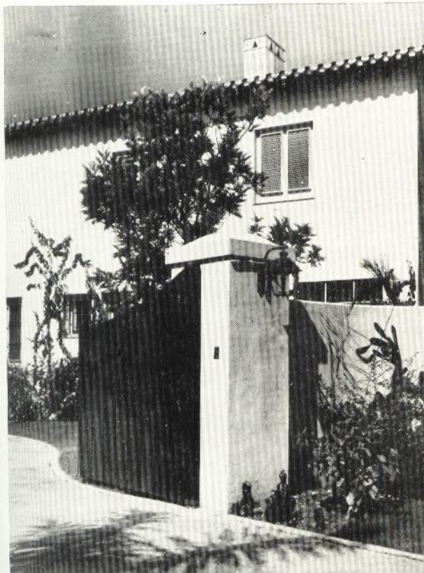
Detalle de la fachada posterior.
