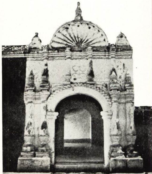
Casa "de las ventanas de hierro", en Coro.
