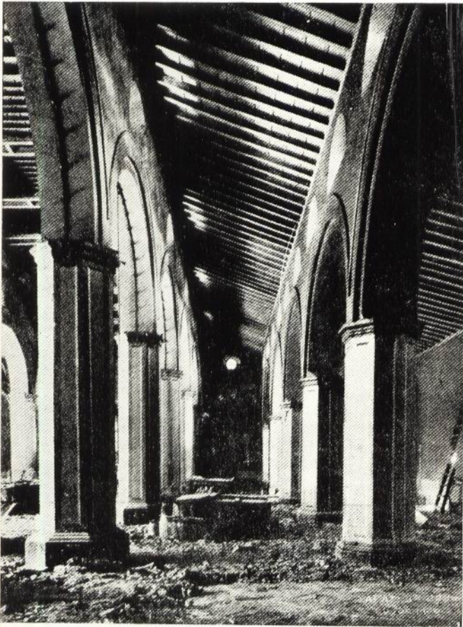
Interior de la Catedral de Caracas, antes de la última reforma.
