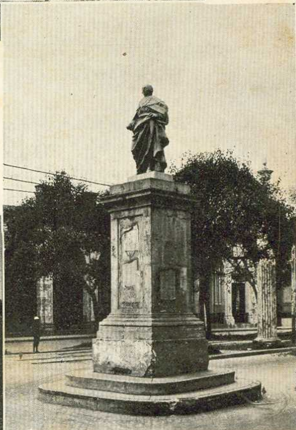
Estado actual de la estatua y del Paseo de Carlos III, que permite apreciar el estado de deterioro en que se encuentra
