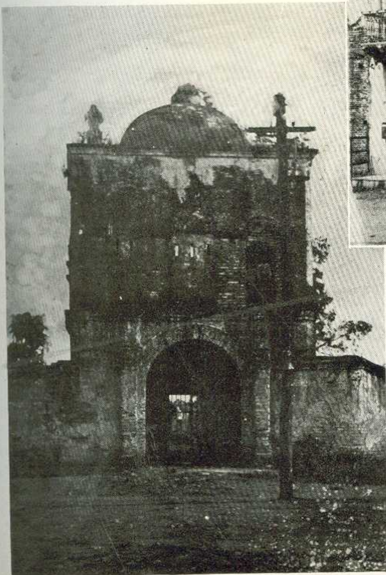
Pórtico del Cementerio Viejo, donde reposan los restos de ilustres patriotas cubanos
